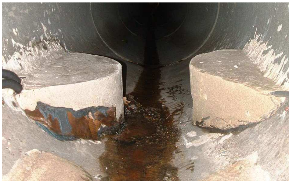
(a) Vue générale
