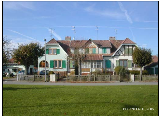
Photo 16: Maison d'ouvrier à quatre logements (Cité Joseph-Else, Wittelsheim). Cet immeuble, typique du Bassin potassique, associe l'originalité de ce territoire et la tradition alsacienne. On retrouve sur l'aile droite l'usage de faux colombages ainsi qu'en façade des pans de toit coupés.
