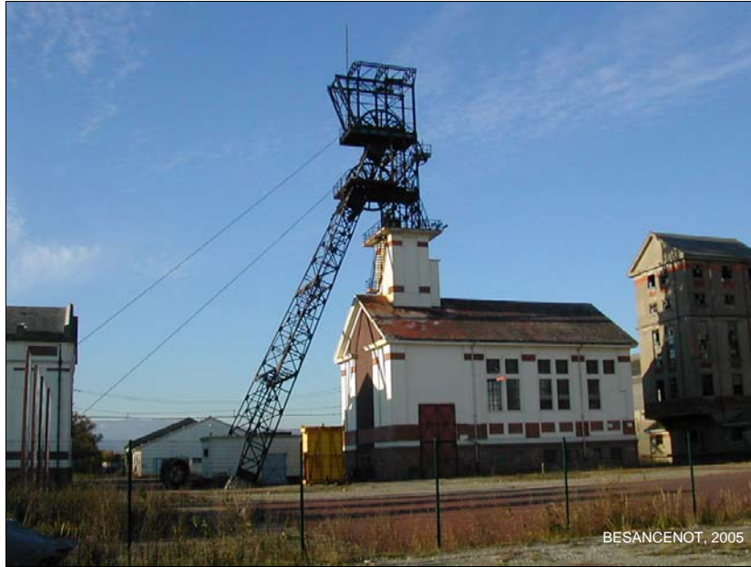
Photo 32: Le carreau Rodolphe réhabilité en musée (Pulversheim). Ce carreau, fermé depuis 1976, a été retenu comme site témoin d'une activité minière désormais révolue. Sauvé de la démolition par l'Ecomusée en 1987, ce dernier a été intégré au parcours muséologique afin de compléter l'histoire de la ruralité alsacienne par l'autre histoire : celle des ressources du sous-sol qui sont venues compenser la faiblesse des ressources de la terre. Ainsi le monde minier et industriel suit la visite du village rural. Le carreau Rodolphe est le seul du bassin dont les chevalements sont d'origine et n'ont pas été détruits. D'autre part, cette mine a été la mine la plus productive de la Société Kali Sainte-Thérèse : 50 millions de tonnes de sel brut ont été produits entre 1913 et 1976. Ce qui explique en partie sa dimension de site phare dans le Bassin potassique.
