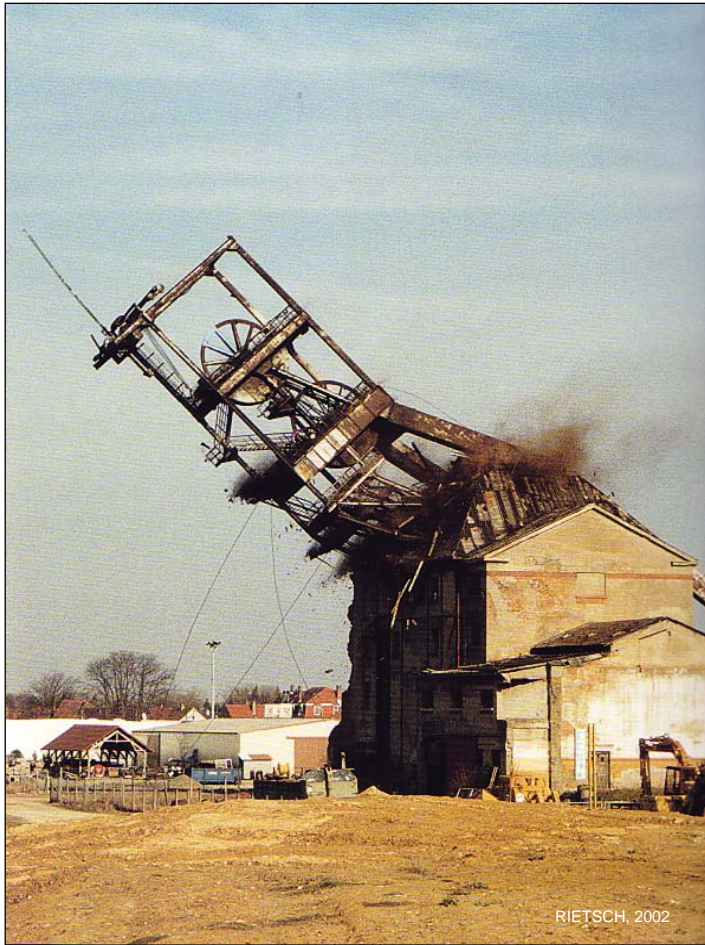
Photo 28: Abattage du chevalement Ensisheim I en mars 1999 (Ensisheim). Plus de 16 millions de tonnes de minerai ont été extraites jusqu'en 1961, date d'arrêt de son exploitation. Le puits est remblayé en 1989. Le chevalement, photographié ici, après dix longues années de décrépitude, est finalement abattu le 17 mars 1999. « Un à un, les chevalements qui faisaient la fierté du bassin sont abattus. Dans la poussière, avec un fracas de poutres broyées, des mastodontes s'effondrent. Pour les anciens, qui viennent parfois assister à cet ultime spectacle, c'est un moment de forte émotion. Ils sont tristes, mais regrettent-ils la mort de cet univers si dur et si contraignant? Les sentiments sont partagés. » (RIETSCH, 2002).
