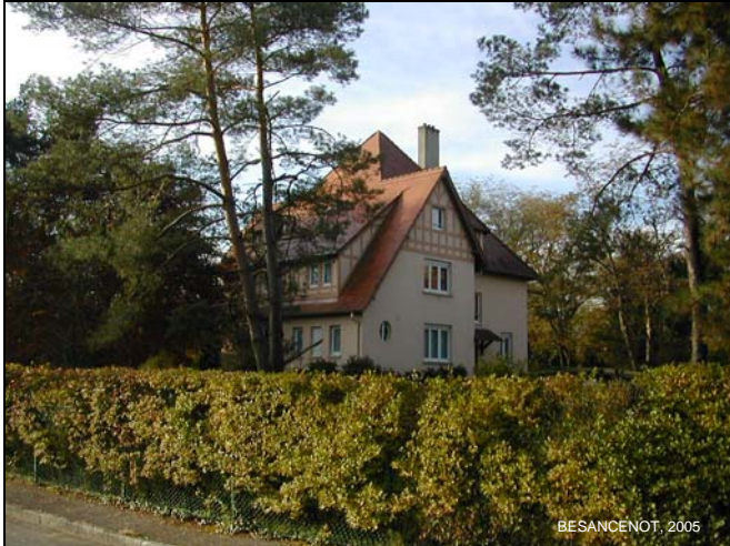
Photo 13: Une maison d'ingénieur (cité Rossalmend, Staffelfelden). Située à proximité directe de carreau de mine, afin de permettre à l'ingénieur d'intervenir, s'il y a lieu, le plus rapidement possible, sa maison se démarque des autres logements par son confort exceptionnel et le soin pris à son entretien; mais aussi par son espace intérieur (170 à 190 m 2 ) et extérieur (près d'un hectare de terrain).
