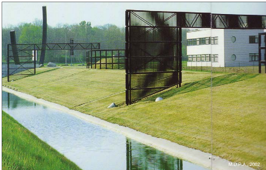
Photo 33 : L'Aire de la Thur, une zone artisanale conçue ex-nihilo. Elle se situe au centre du Bassin potassique, sur le lieu d'anciennes friches industrielles M.D.P.A.. Le projet initial, soutenu par la Commission Européenne a été d'attirer des entreprises afin d'assurer la reconversion du bassin minier. Outre l'installation d'entreprises, l'aspect social a aussi été mis en avant : il doit favoriser la formation professionnelle. Ce projet a été subventionné par le FEDER, dans le cadre de l'objectif 2, pour un montant de 11 millions de francs sur 5 ans (PREFECTURE REGION ALSACE, 2005). « Par ses dimensions (45 ha), la qualité de ses aménagements et de son paysagement, ce parc d'activités s'est affirmé comme l'un des plus attractifs d'Alsace. » (C.A.M.S.A., 2004).
