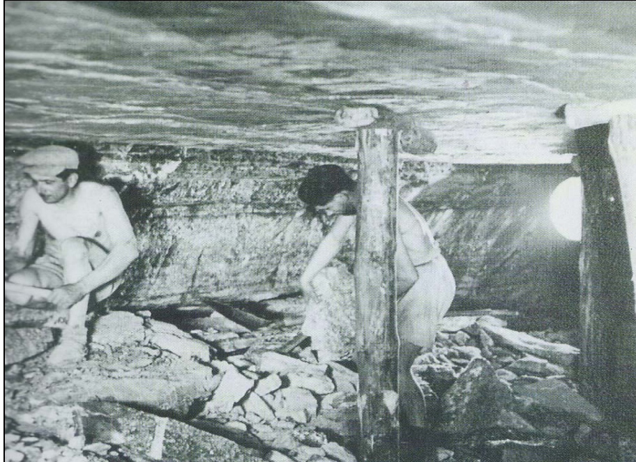
Photo 17 : Mineurs à l'époque du "tout manuel" (années 1920). Jusqu'à la Seconde guerre mondiale, le travail au fond se fera essentiellement à la main (aussi bien l'extraction du minerai que les soubassements en bois tels qu'on peut les observer sur la photo). La pelle surnommée "Dr Loeffel" (la cuillère) constituera le principal outil du mineur. Le port du casque ne sera obligatoire qu'après guerre. Le plus souvent, les mineurs portaient des casquettes, des bérets et des calottes découpées dans des chapeaux de femme.
