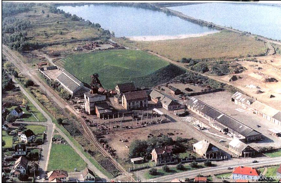
Photo 25: Un carreau minier désaffecté après fermeture (Amélie II, Wittelsheim). 29 Ce puits de mine, fermé depuis 1950 est longtemps resté friche industrielle. Les anciens vestiaires, hangars et chevalements sont actuellement en cours de démolition. Le code minier impose en effet à l'industriel, après l'exploitation, de remettre le terrain en état. Afin de limiter les risques de pollution ou de chute impromptue de certains éléments, le carreau est, la plupart du temps, voué à une démolition certaine ainsi qu'à des travaux de dépollution, notamment pour éviter toute infiltration dans le sol de sel contenu dans les terrils. Dans le but d'éviter des infiltrations, le terril Amélie II a fait l'objet d'une étanchéification puis d'une révégétalisation.
