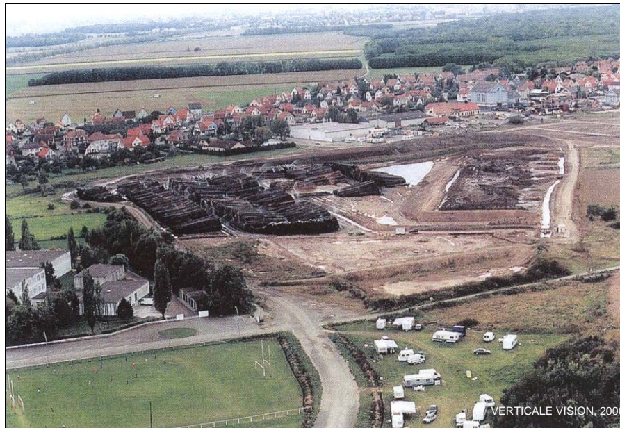
Photo 26: Un carreau détruit et rasé après fermeture (Ensisheim Est, Ensisheim). Les M.D.P.A., conformément aux normes de sécurisation mentionnées par le code minier, ont organisé la démolition complète du carreau de
