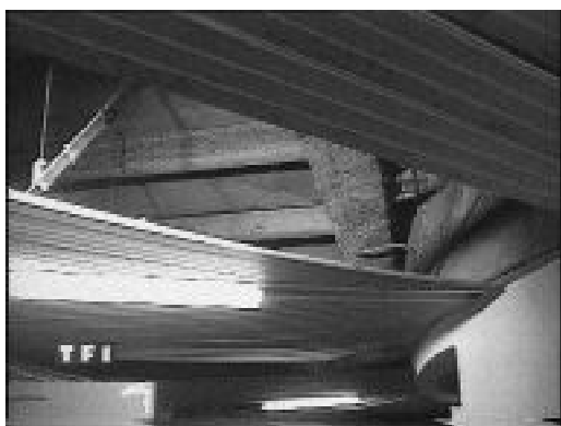
Ces deux plans forment un zoom avant sur un tuyau recouvert d'une pellicule d'amiante dans un faux plafond ouvert.
