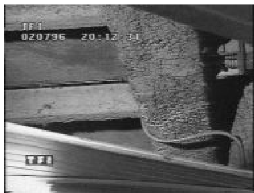
Ces deux plans forment un zoom avant sur un tuyau recouvert d'une pellicule d'amiante dans un faux plafond ouvert.
