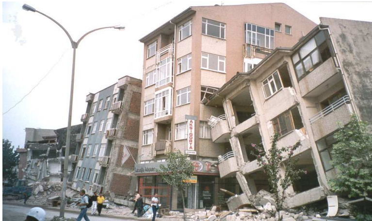
Figure 1- Séisme Izmit - Turquie [Site web AFPS]
