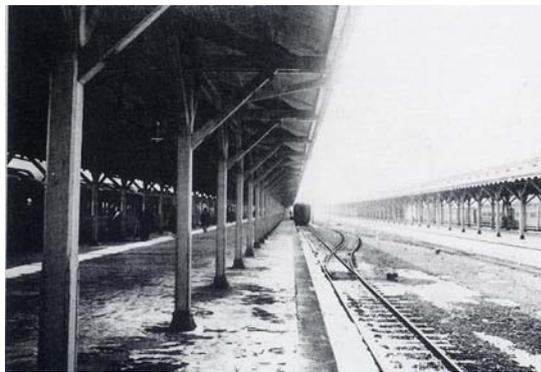
Figure 823 Aomori I (1891), ferme à poinçon (king post truss)
