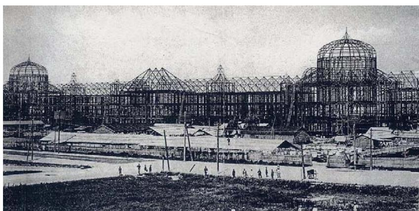
Figure 797 Ossature de la gare de Tokyo (1914)
