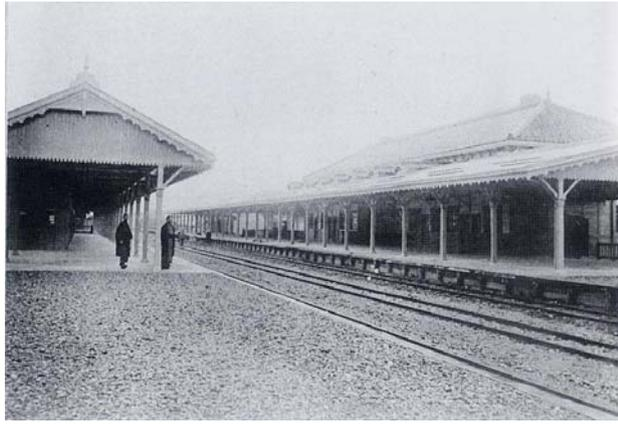
Figure 825 Toyama (1908), ferme à poinçon et l'avant-toit attaché au bâtiment
