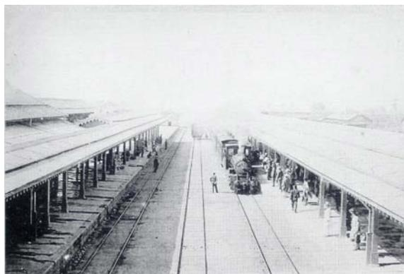
Figure 824 Yamagata (1901), ferme à poinçon et celle en forme de « Y »
