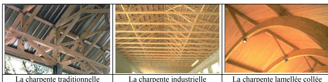
Figure 7– Les divers types des charpentes en bois
