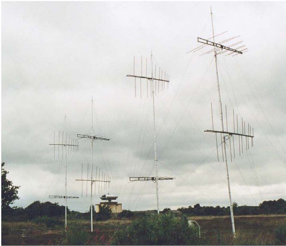
FIG. 2.2 - Vue des réseaux d'antennes du système MOSAR.
