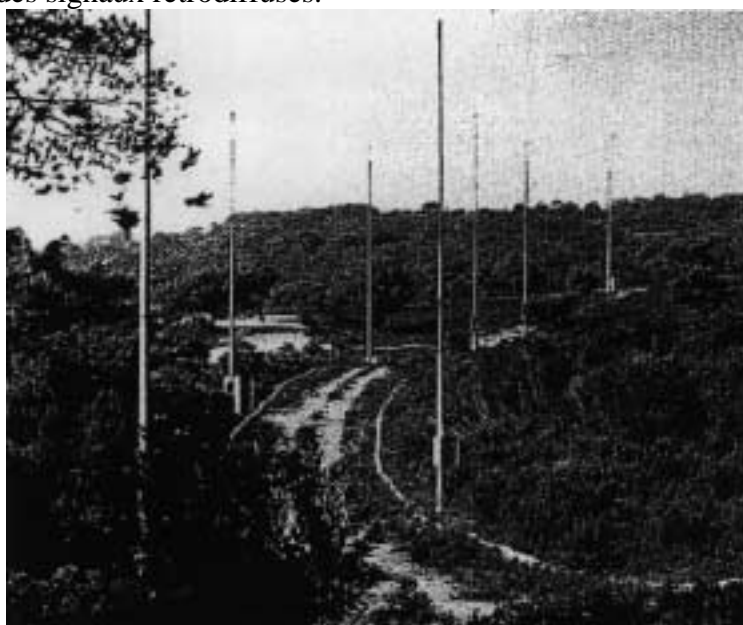
Figure I.3.9 : Vue du système d'aérien du radar R.I.A.S. [27].
