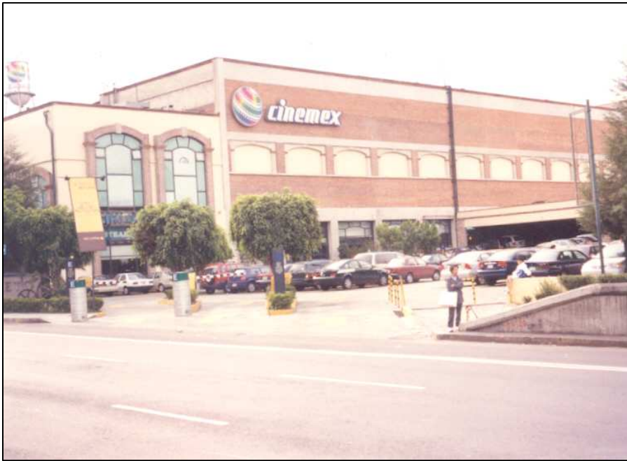
Photographie 9 : L'entrée principale en situation rare d'absence de circulation, laissant voir la longue façade du bâtiment est
