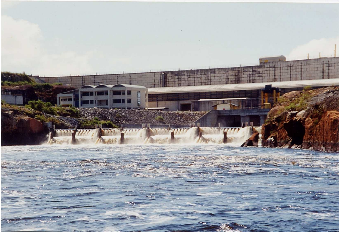
FIG. 2.4 – Le seuil aérateur situé en aval des turbines du barrage de Petit-Saut.
