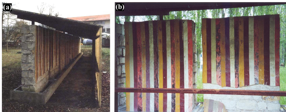
Figure IV-1: (a) Vue générale de deux des murs peints expérimentaux construits sous abri ouvert en 1977 pour le Laboratoire de Recherche des Monuments Historiques (LRMH, Champs-sur-Marne). (b) Vue des murs référencés 1.4 et 2.1. ©LRMH 1998.
