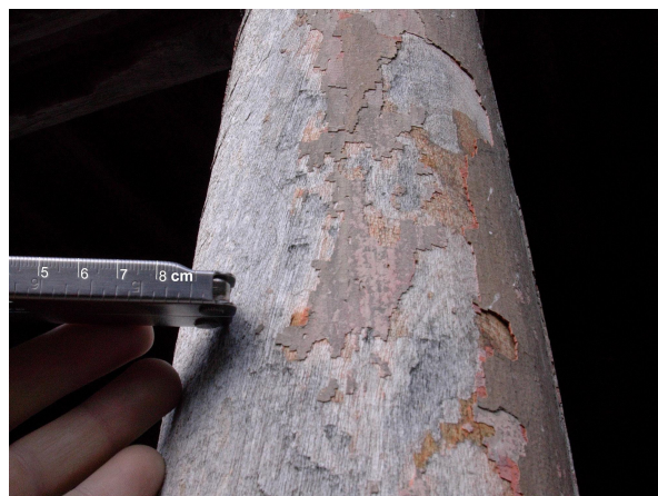
Figure IV-88: Lieu de prélèvement des échantillons sur un des piliers du Pavillon de la favorite arabe de Moulay Ismail.
