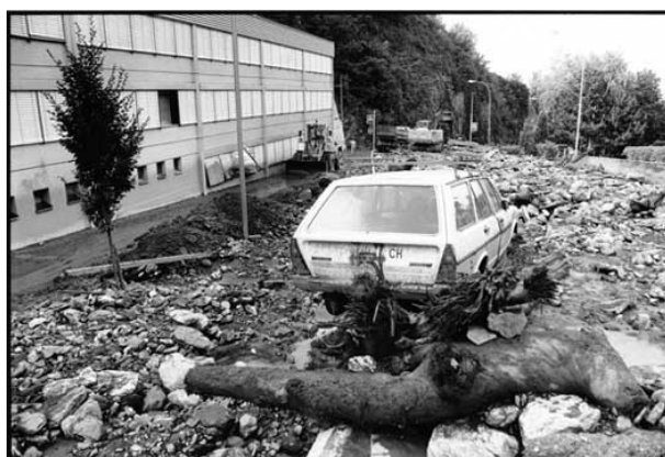
C. Inondation de la route du Rawyl, à l'apex du cône, lors de la crue de la Sionne en juillet 1992 089ph-00725
