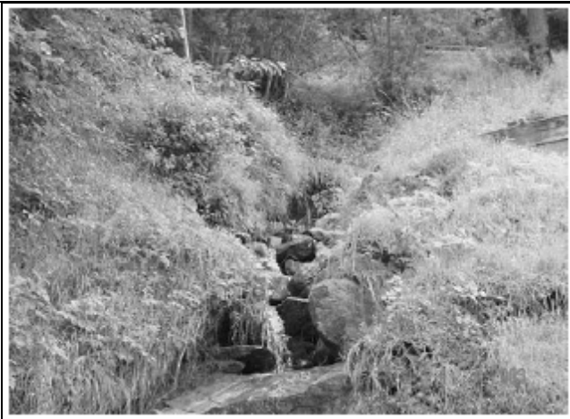
A. Hérémece, torrent de Tzénaz avant travaux
