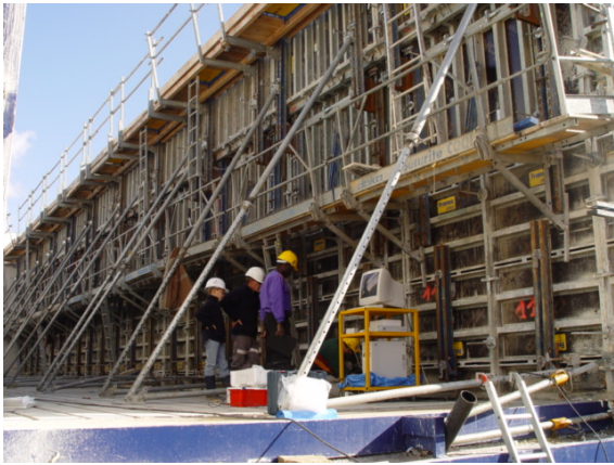
Figure 23 : Vue du coffrage in-situ
