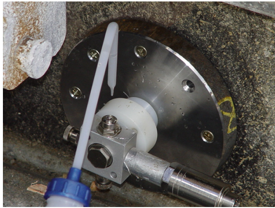
Figure 24 : adaptation du capteur de pression interstitielle en pied de coffrage
