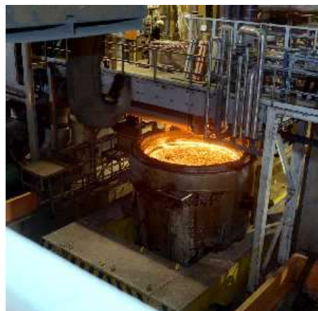
Figure 1.1 : Poche de traitement d'acier
