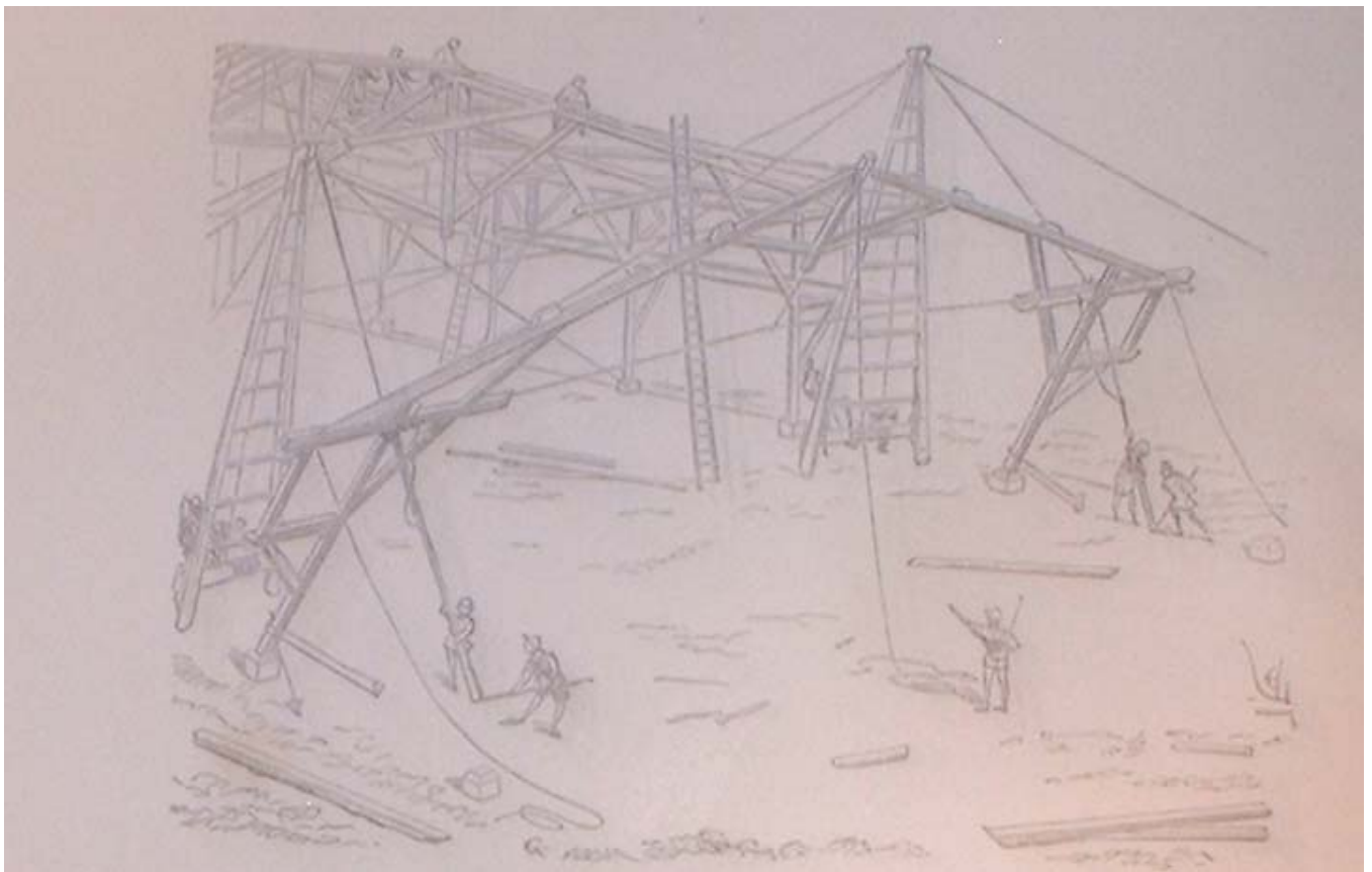
Illustration 7.8, levage d'une charpente, histoire d'un dessinateur, Viollet le Duc, 20x12cm.
