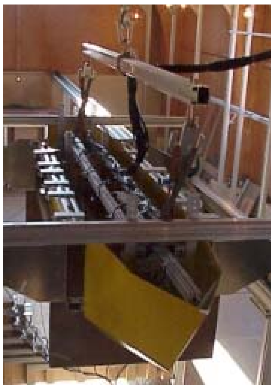
Figure 4.19 : Structure interne des capteurs et maquette
