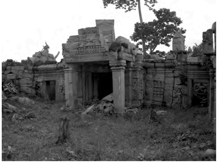
Ph. 433 : Pavillon d'entrée central BT.6 et vestibules traversants latéraux BT.7 et BY.11 de la première enceinte de Banteay Thom
