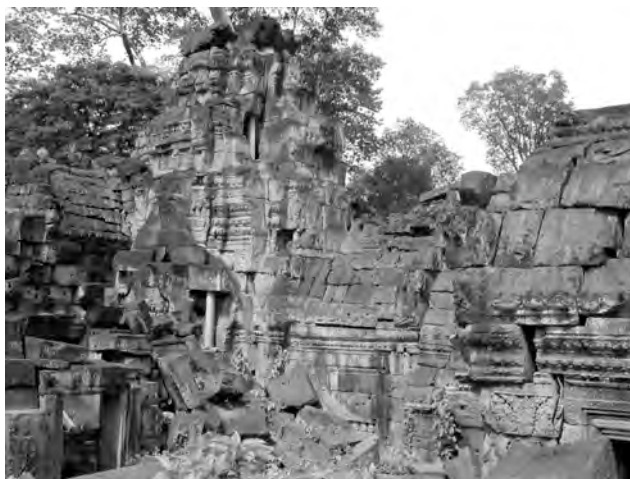
Ph. 345 : Vestiges de la tour PK.30 (à gauche) et tour PK.31
