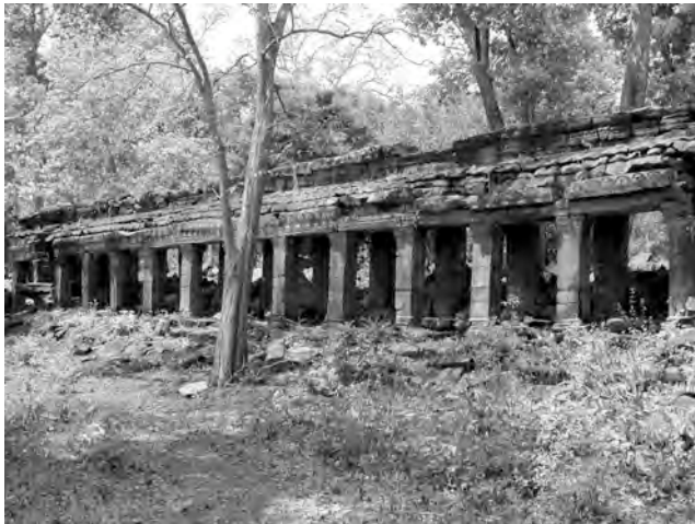
Ph. 453 : Vestiges de la galerie Sud BC.144 de la troisième enceinte de Banteay Chmar
