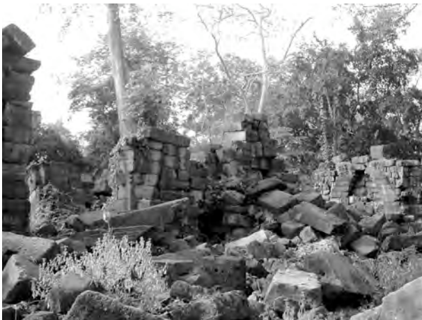
Ph. 474 : Vestiges du sanctuaire central BC.62 et de sa salle hypostyle BC.63 du complexe occidental
