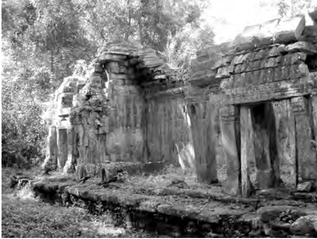
Ph. 291 : Vestiges de la galerie ouverte PK.151 et du pavillon d'extrémité PK.152 de l'entrée orientale de l'enceinte du temple
