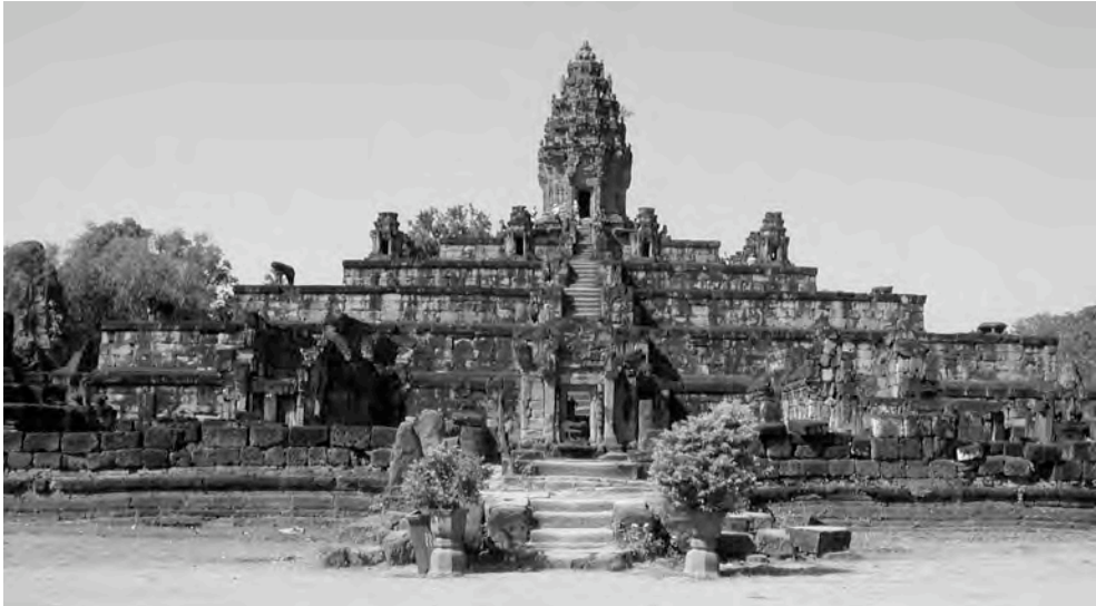
Ph. 1 : Face orientale du Bakong (la tour-sanctuaire principale date du XI e siècle)
