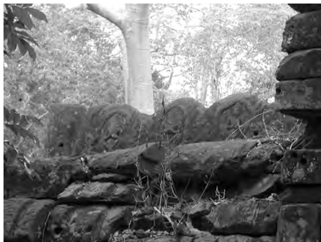
Ph. 905 : Faîtages à rishi de l'avant-corps Nord du pavillon axial BC.73 du premier complexe occidental
