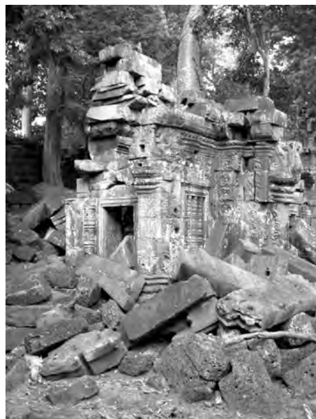
Ph. 125 : Tour PK.50 (vue du trois-quarts Nord-Est)
