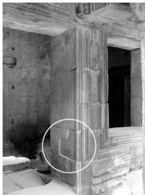
Ph. 622 : Exemple d'un piédroit d'une fenêtre transformée en porte à la troisième enceinte de Ta Prohm présentant une lacune
