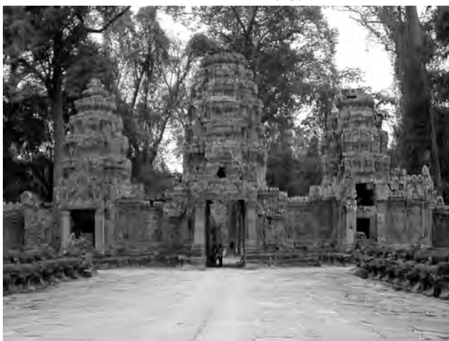
Ph. 276 : Face Nord des pavillons d'entrée PK.182, 183 et 184 de la porte Nord de l'enceinte de domaine du Preah Khan d'Angkor
