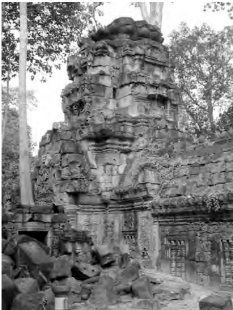
Ph. 259 : Pavillon d'entrée Nord TN.21 de la première enceinte de Ta Nei
