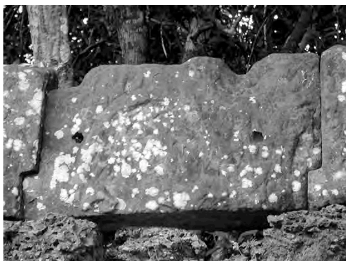
Ph. 645 : Face extérieure ébauchée des faîtages de type 4 du mur de l'enceinte de domaine de Ta Som
