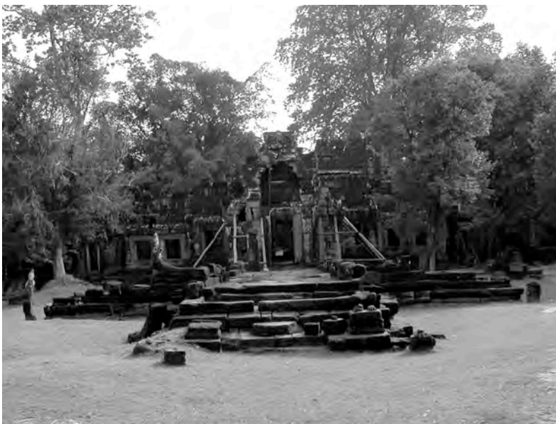
Ph. 182 : Chaussée cruciforme BK.53 précédant le pavillon d'entrée occidentale BK.49 de l'enceinte du temple
