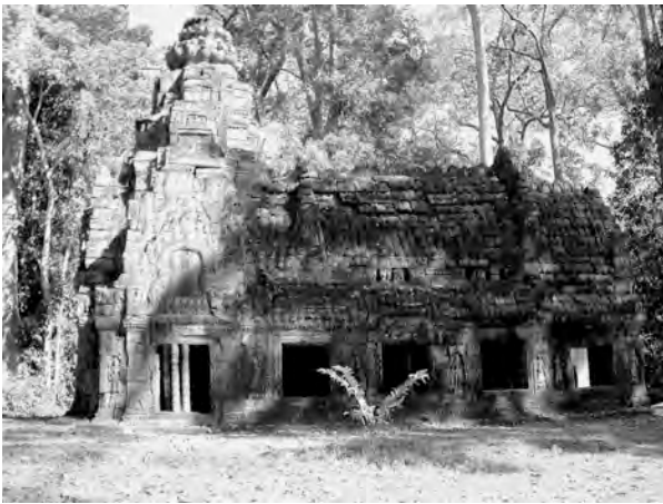
Ph. 281 : Face Sud du gîte d'étape PK.170
