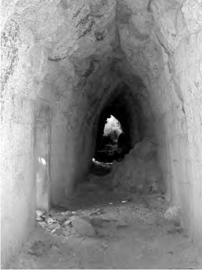
Ph. 432 : Vue intérieure de la galerie Sud BT.8 de la première enceinte de Banteay Thom
