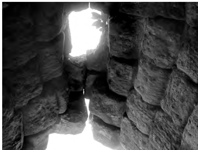
Ph. 883 : Intrados de la voûte originelle de la “bibliothèque” Sud BK.7
