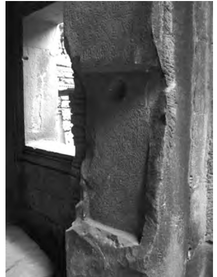
Ph. 758 : Piédroit Sud de la porte orientale du pavillon axial Est PK.36 de la première enceinte du Preah Khan d'Angkor
