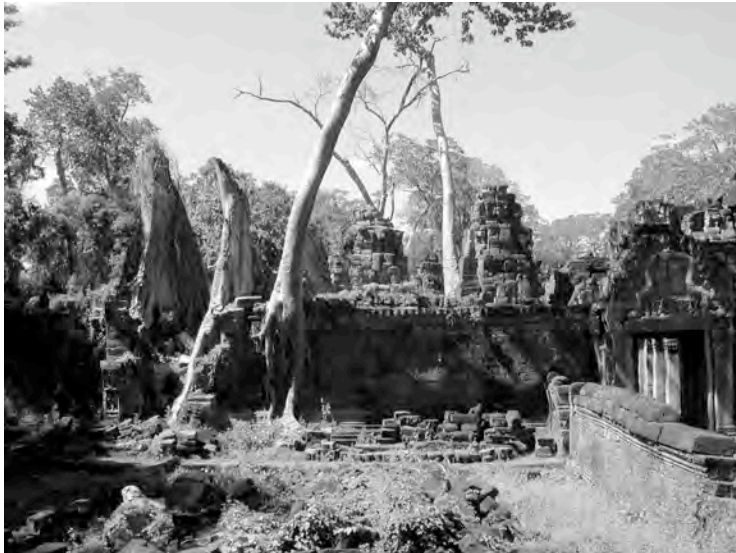
Ph. 329 : Tronçon Sud de la galerie orientale de la seconde enceinte PK.54
