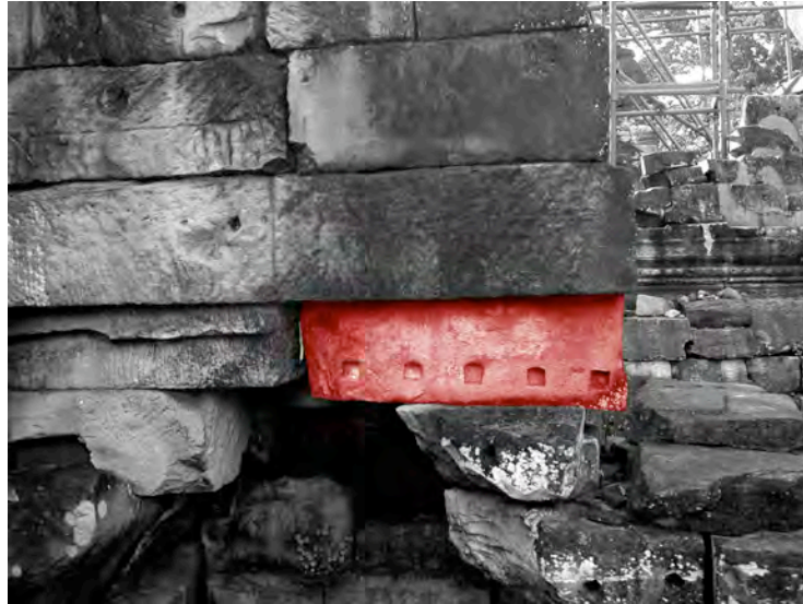
Ph. 803 : Exemple de bloc en réemploi dans la cheminée de la tour PK.30 du Preah Khan d'Angkor
