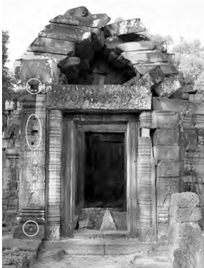
Ph. 836 : Avant-corps Est du sanctuaire de Krol Kô
