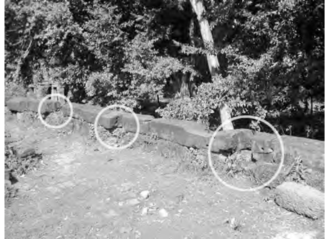
Ph. 872 : Muret Nord de l'édifice PK.44 du Preah Khan d'Angkor présentant des réservations pour des piliers en bois
