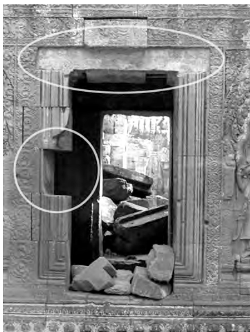
Ph. 621 : Exemple d'un piédroit d'une fausse-fenêtre transformée en porte à la première enceinte de Ta Prohm présentant une lacune
