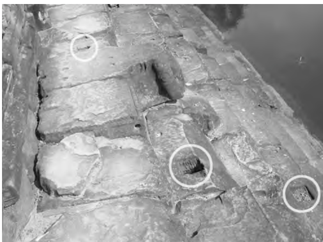
Ph. 865 : Mortaises de part et d'autre de la vasque de l'édifice du bassin secondaire Ouest
