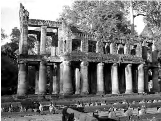
Ph. 317 : Face Sud de l'“édifice à colonnes” PK.146
