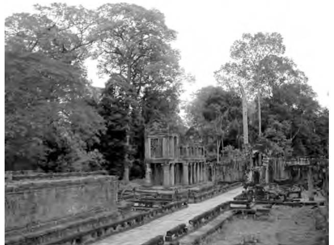
Ph. 314 : Chaussée Nord PK.147
