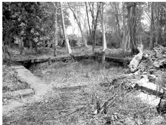
Ph. 551 : Courette Nord-Ouest de la plateforme PKKS.24
