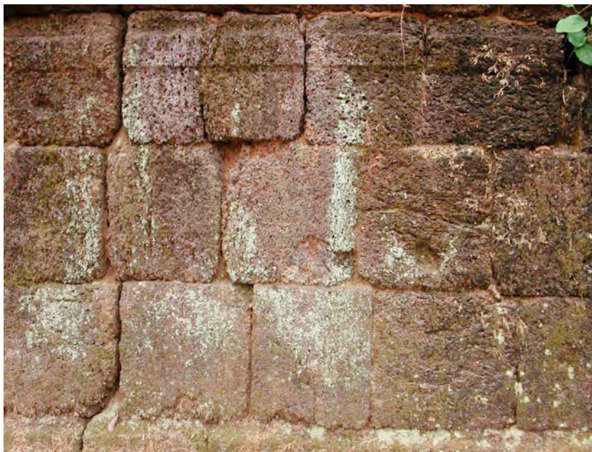
Ph. 31 : Mur d'enceinte en latérite au Prasat Thom de Koh Ker
