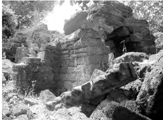
Ph. 435 : Vestiges du pavillon d'entrée occidentale BT.9 de la première enceinte de Banteay Thom
