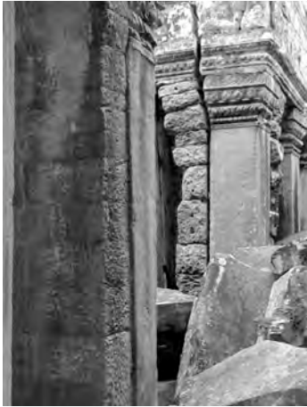
Ph. 186 : Restauration antique des piliers intérieurs du pavillon d'entrée occidental BK.49 de l'enceinte du temple
