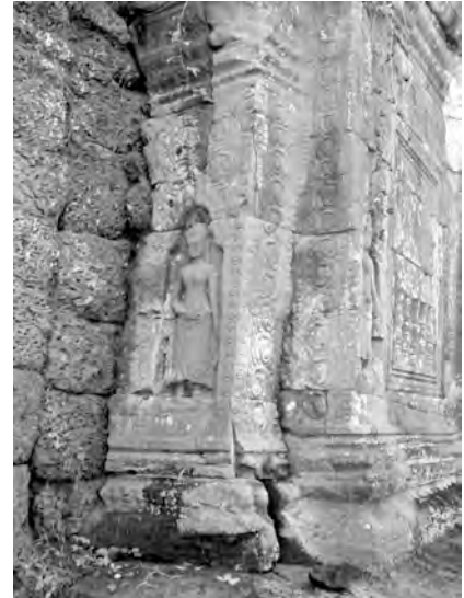
Ph. 280 : Connexion entre le mur de l'enceinte de domaine et le pavillon d'entrée latérale Nord PK.173 de la porte orientale
