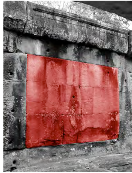
Ph. 674 : Face intérieure de la galerie de la première enceinte de Ta Kev
