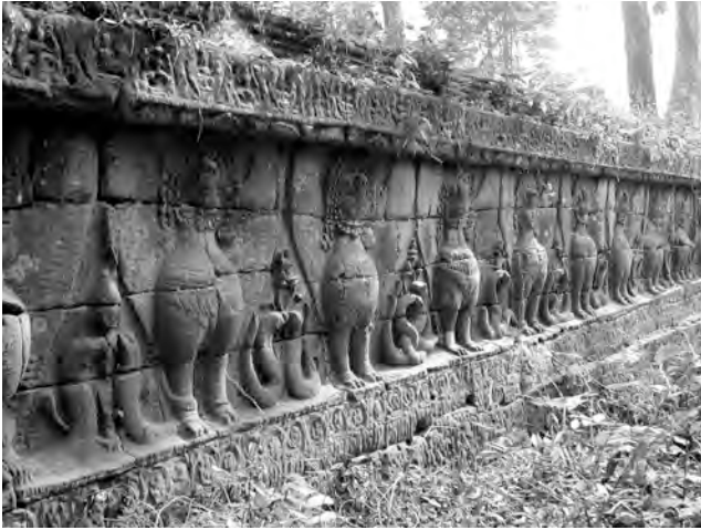
Ph. 538 : Mur de soutènement de la chaussée-digue PKKS.91 précédant le gopura oriental de l'enceinte de domaine du Preah Khan de Kompong Svay
