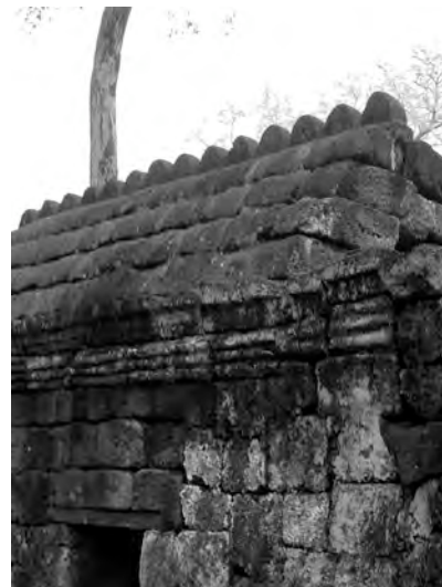
Ph. 644 : Faîtage de type 4 en latérite de la première enceinte de Muang Sing (Thaïlande)
