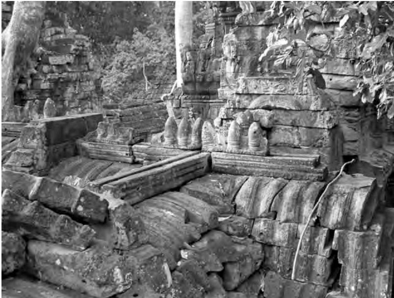
Ph. 631 : Extrados du pavillon Sud TP.75 du " cloître " Nord de Ta Prohm montrant le résultat de l'assemblage de la première variante du second modèle de faitage ( Type 2 )
