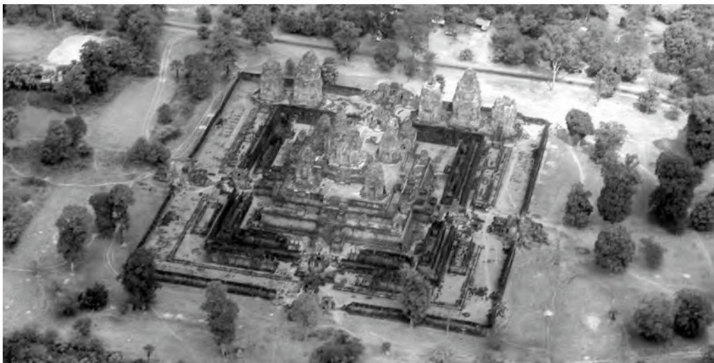
Ph. 4 : Vue aérienne de Pre Rup
