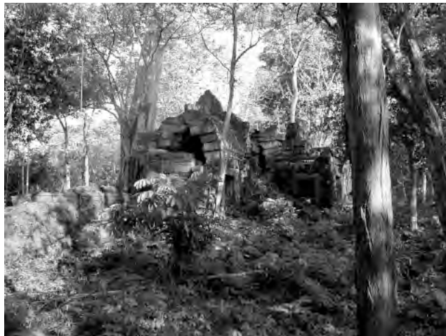
Ph. 527 : Vestiges d'un des pavillons d'entrée de l'enceinte du Preah Thkol (photo de Naoki Hatano)
