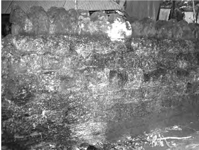
Ph. 978 : Faîtage de type 4 du mur d'enceinte du Krol Romeas
