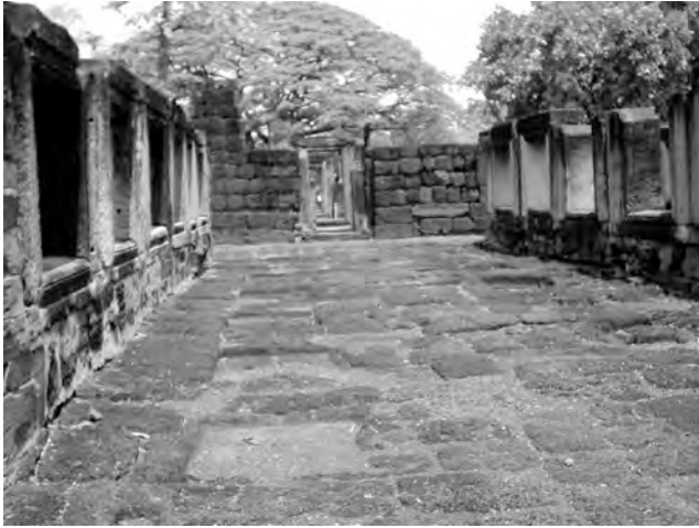
Ph. 595 : Corps central de l'annexe Sud PH.26 présentant des logements de pilier dans son dallage
