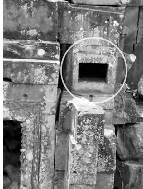
Ph. 975 : Logement de poutre dans la maçonnerie de l'avant-corps oriental du pavillon axial PKKS.5 de la première enceinte du complexe central du Preah Khan de Kompong Svay
