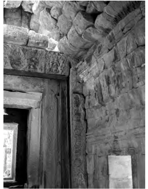
Ph. 242 : Vue intérieure de la "salle-passage" BK.10
