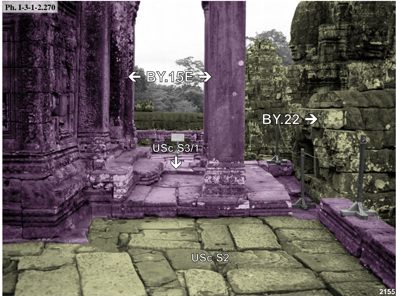
Bayon, porche de l'avant-corps Est de la tour BY.15 et extension S3/1 du dallage du soubassement troisième étage
