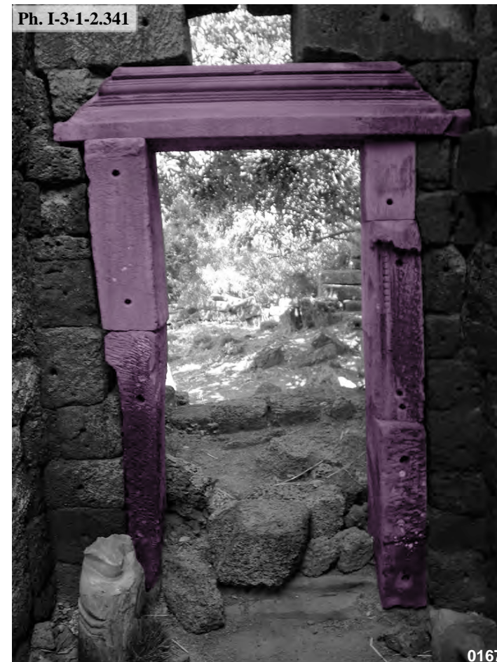
Vat Banon, exemple de réemploi pour la porte de l'avant-corps Nord du pavillon axial VB.10
