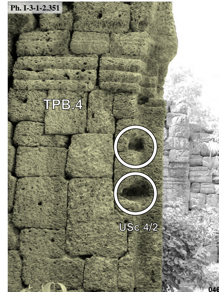
Ta Prohm de Bati, entrée Nord de la tour TPB.4 face Est : USc 4/2
