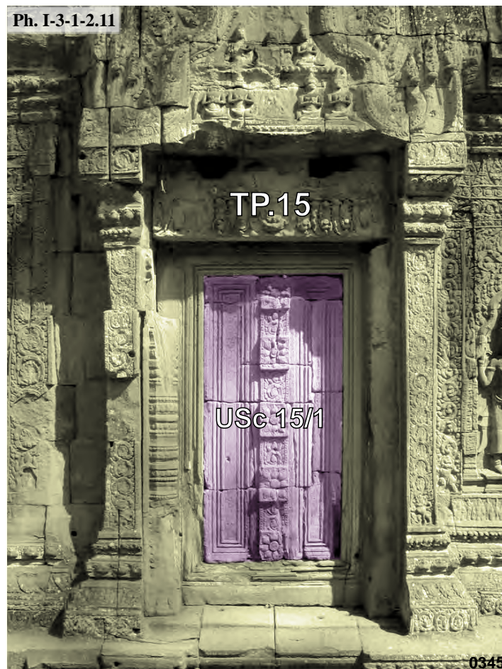
Ta Prohm, porte murée de l'entrée Ouest du tronçon TP.15 de la galerie Ouest : USc 15/1
