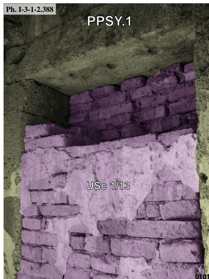
Phra Prang Sam Yod, fenêtre Nord de l'avant-corps Est de la tour centrale PPSY.1 face intérieure: Usc 1/13
