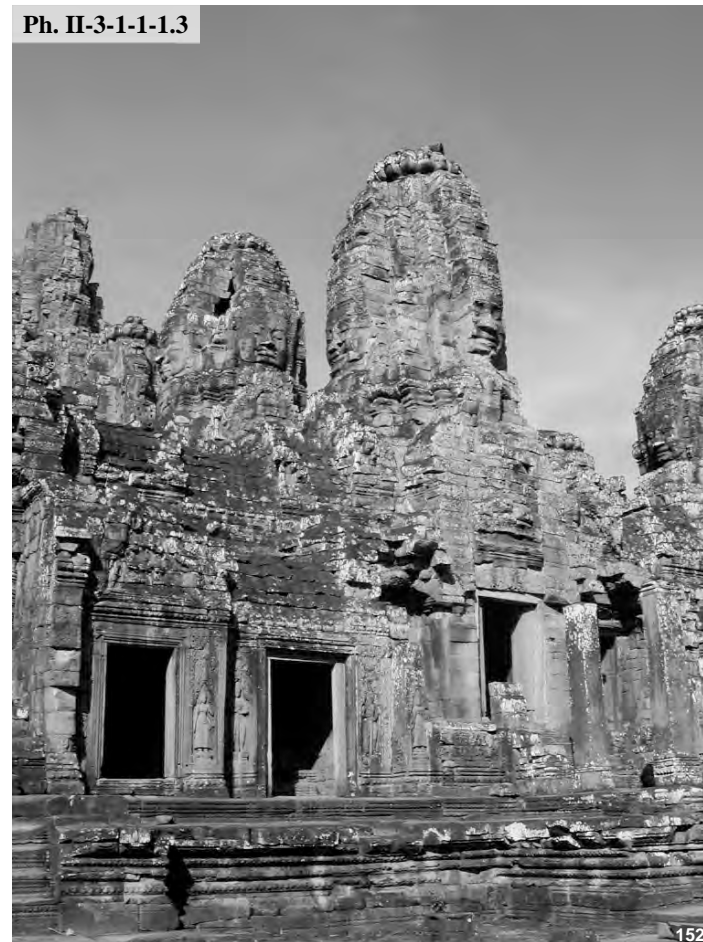
Bayon : enceinte intérieure, tours BY.22 , BY.37 et BY.15
