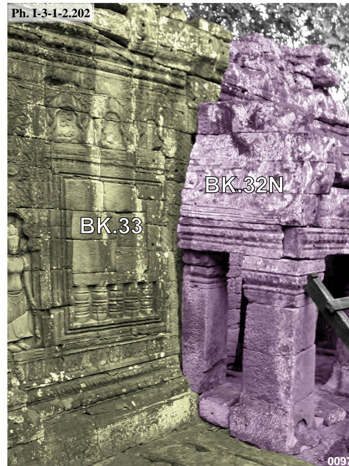
Banteay Kdei, connexion de l'avant-corps Nord de la tour axiale BK.33 de la seconde galerie avec le bas-côté de la galerie BK.32N
