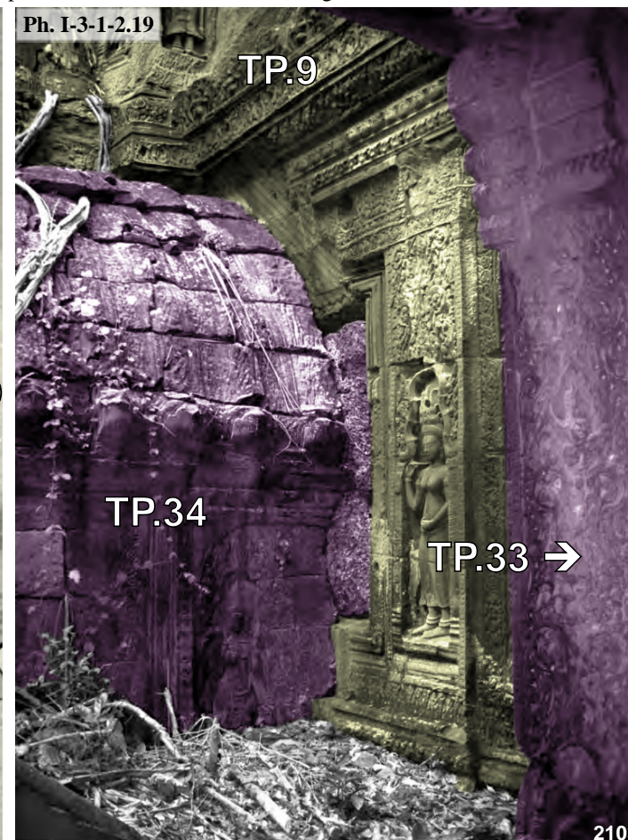
Ta Prohm, connexion entre l'avant-corps Nord de la tour d'angle Sud-Est TP.9 de la première enceinte avec la salle de passage TP.34 , face Nord
