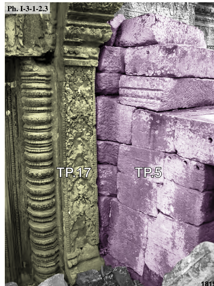
Ta Prohm, connexion entre la salle de passage TP.5 avec le bras Est de la tour axiale Ouest TP.17 , mur intérieur Nord
