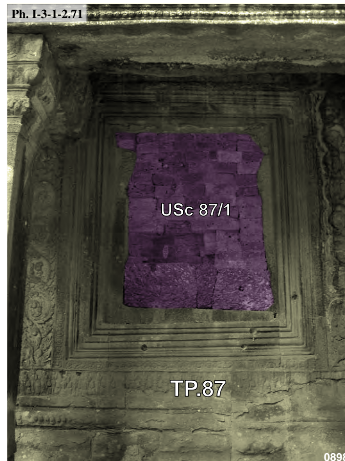
Ta Prohm, fenêtre de l'avant-corps Ouest du pavillon axial Sud TP.87 de la troisième enceinte : USc 87/1
