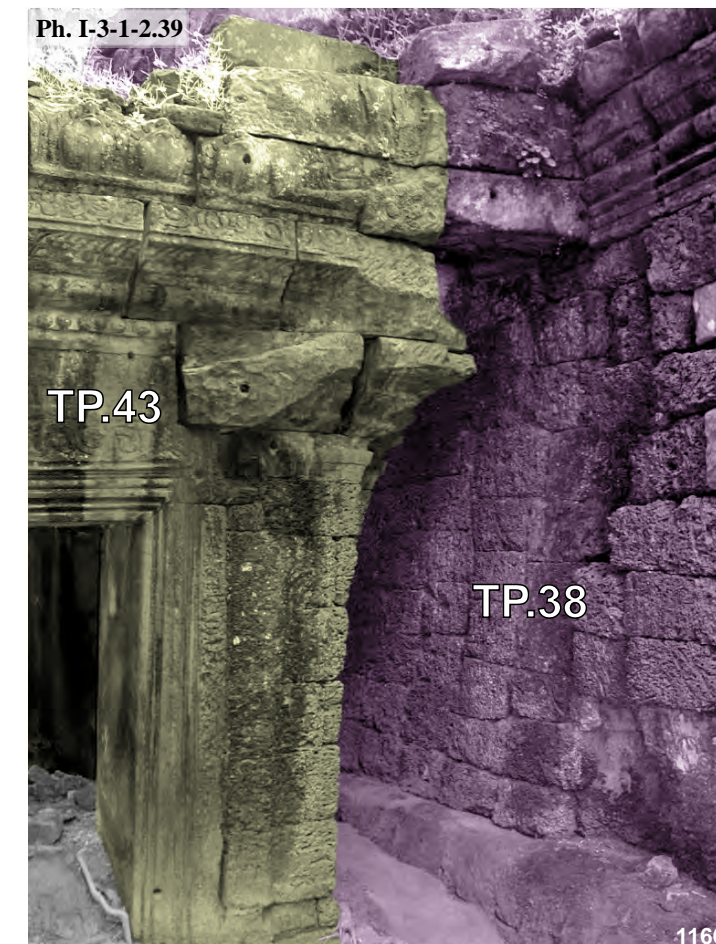
Ta Prohm, connexion entre l'avant-corps Ouest de l'édifice TP.43 avec la seconde galerie-enceinte, vue Nord
