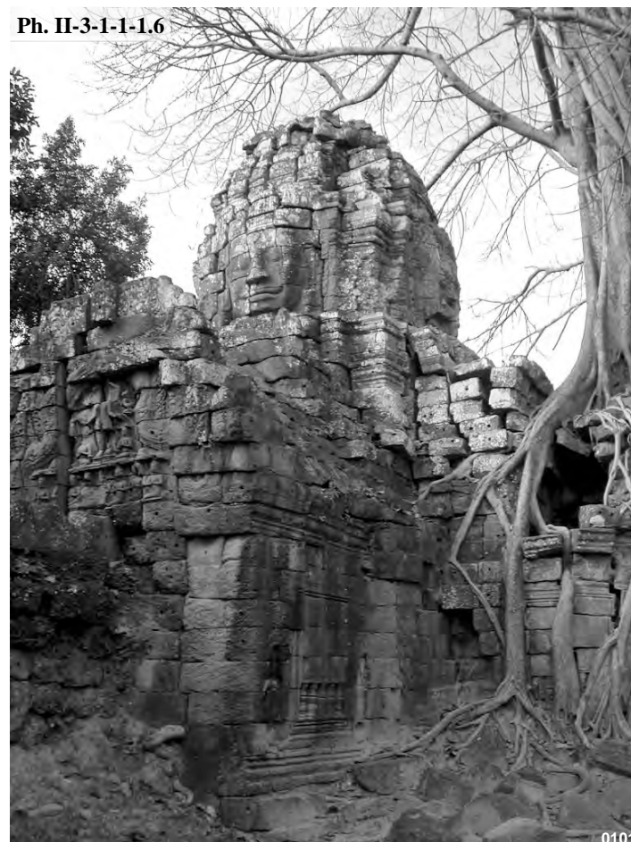
Ta Som : porte Est de l'enceinte de domaine TS.30
