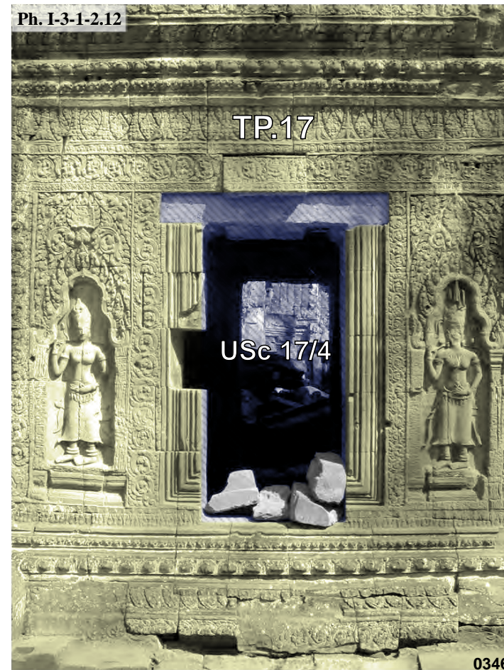
Ta Prohm, fenêtre Ouest de l'avant-corps Sud de la tour axiale Ouest TP.17 de la première enceinte : USc 17/4
