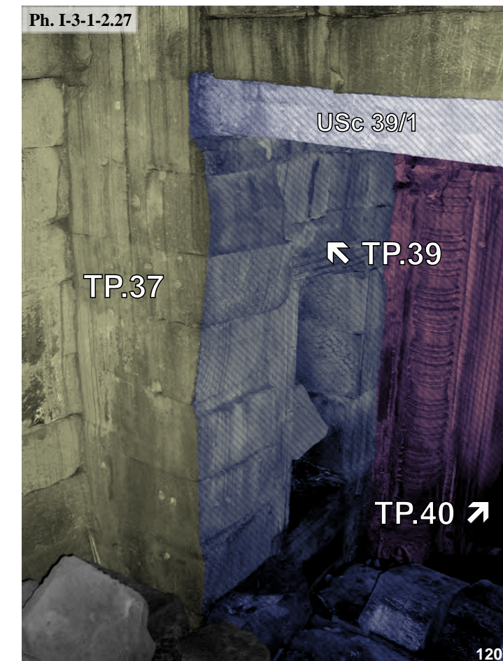
Ta Prohm, ouverture entre la partie Ouest de la galerie du cloître Est et sa connexion TP.39 avec l'avant-corps Ouest de la tour TP.40 : USc 39/1
