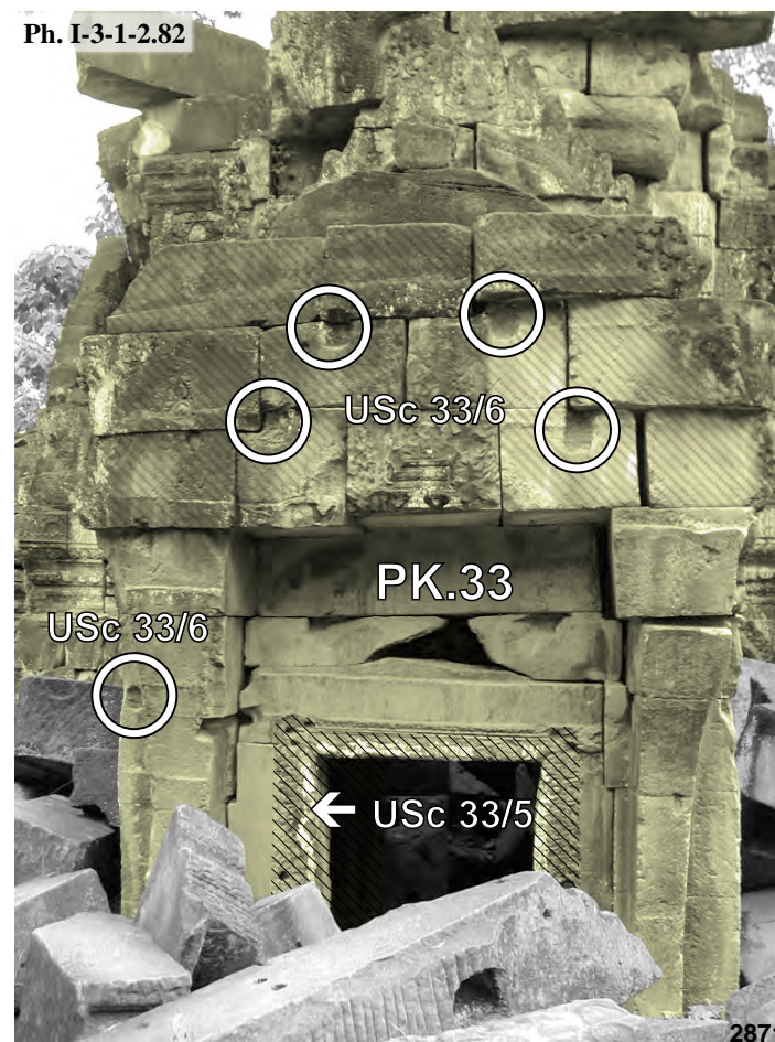
Preah Khan, fronton de l'avant-corps Ouest de la tour PK.33 : USc 33/5 et USc 33/6
