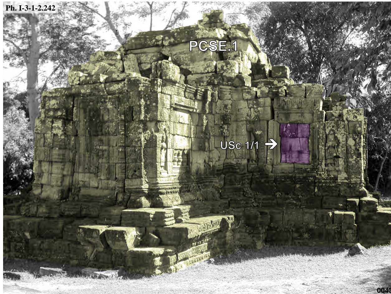
Prasat Chrung Sud-Est d'Angkor Thom, sanctuaire central PCSE.1 angle Sud-Ouest
