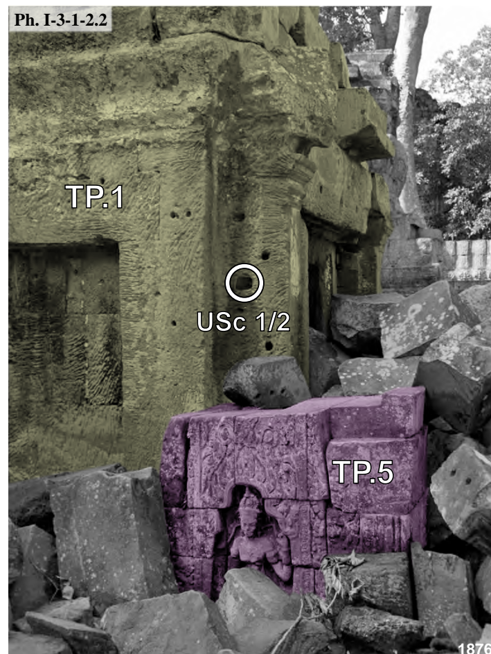
Ta Prohm, connexion entre la salle de passage TP.5 avec l'avant-corps Ouest du sanctuaire central TP.1 , face Nord : USc 1/2
