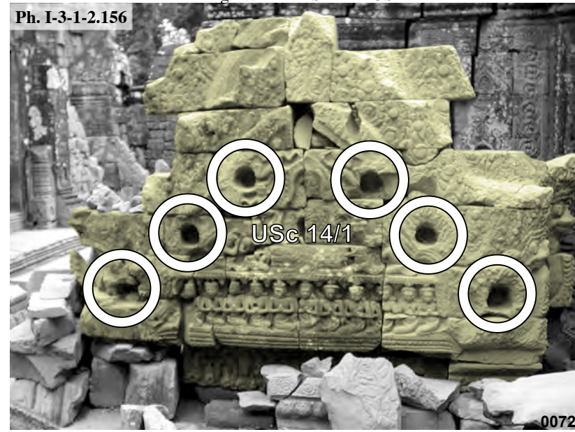
Ta Som, fronton de l'avant-corps Est du pavillon axial Ouest de la première enceinte I TS.14 , remontage WMF/APSARA : USc 14/1
