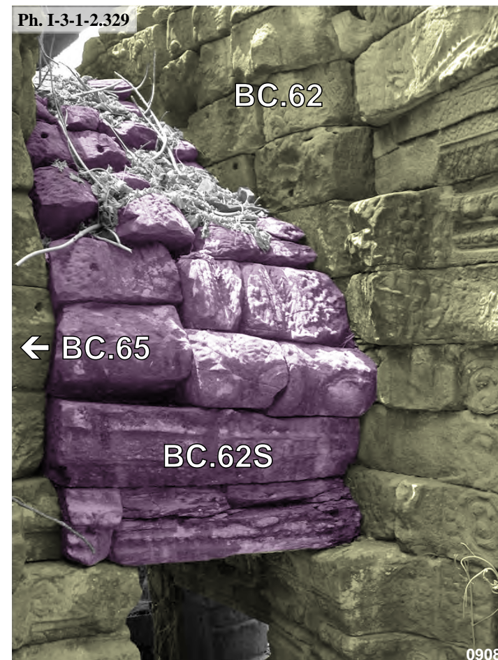
Banteay Chmar, couverture BC.62S formant liaison entre le sanctuaire central BC.62 et la tour BC.65 du complexe Ouest, face Est
