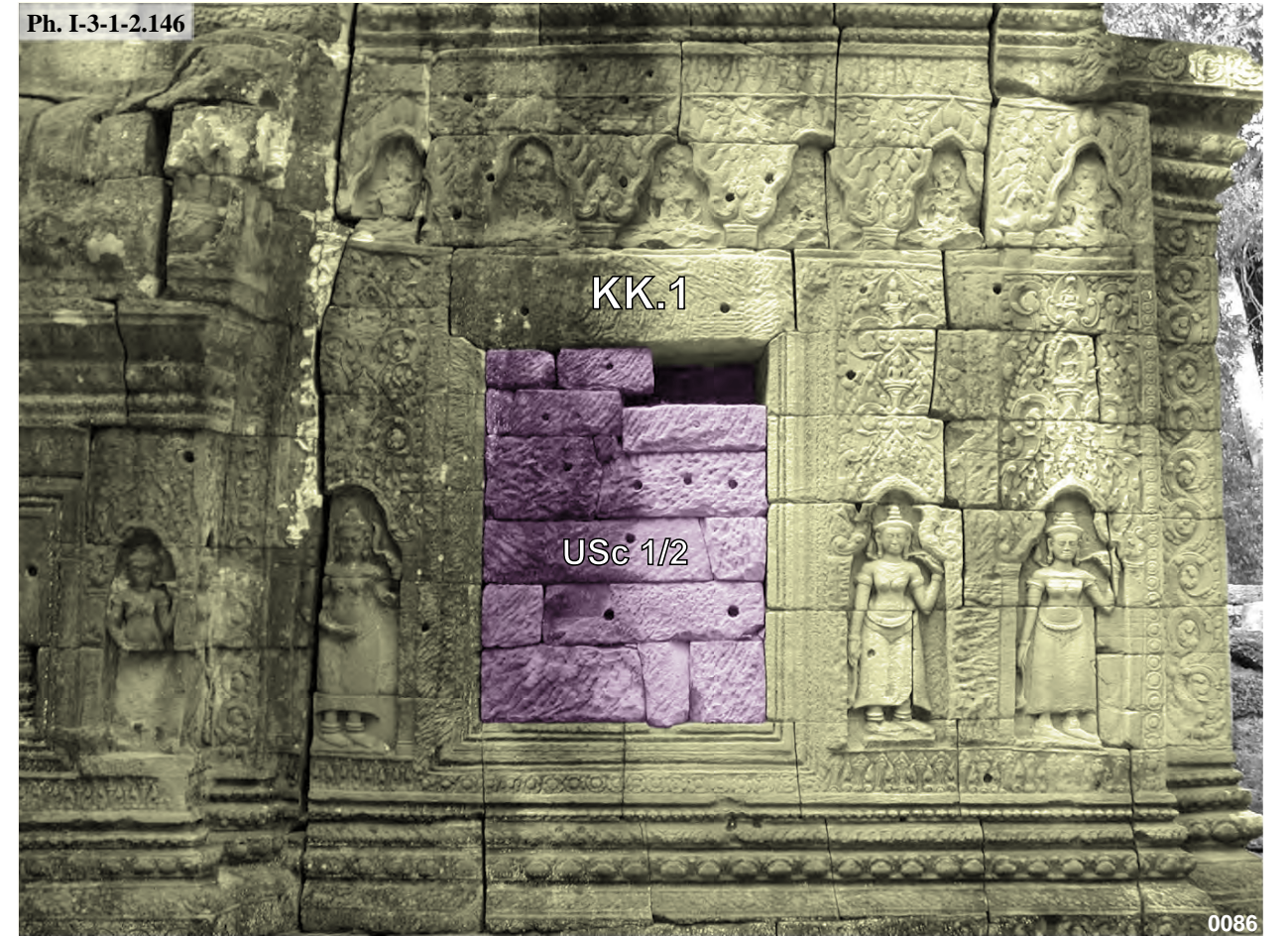
Krol Kô, avant-corps oriental du sanctuaire central KK.1 face Sud : USc 1/2
