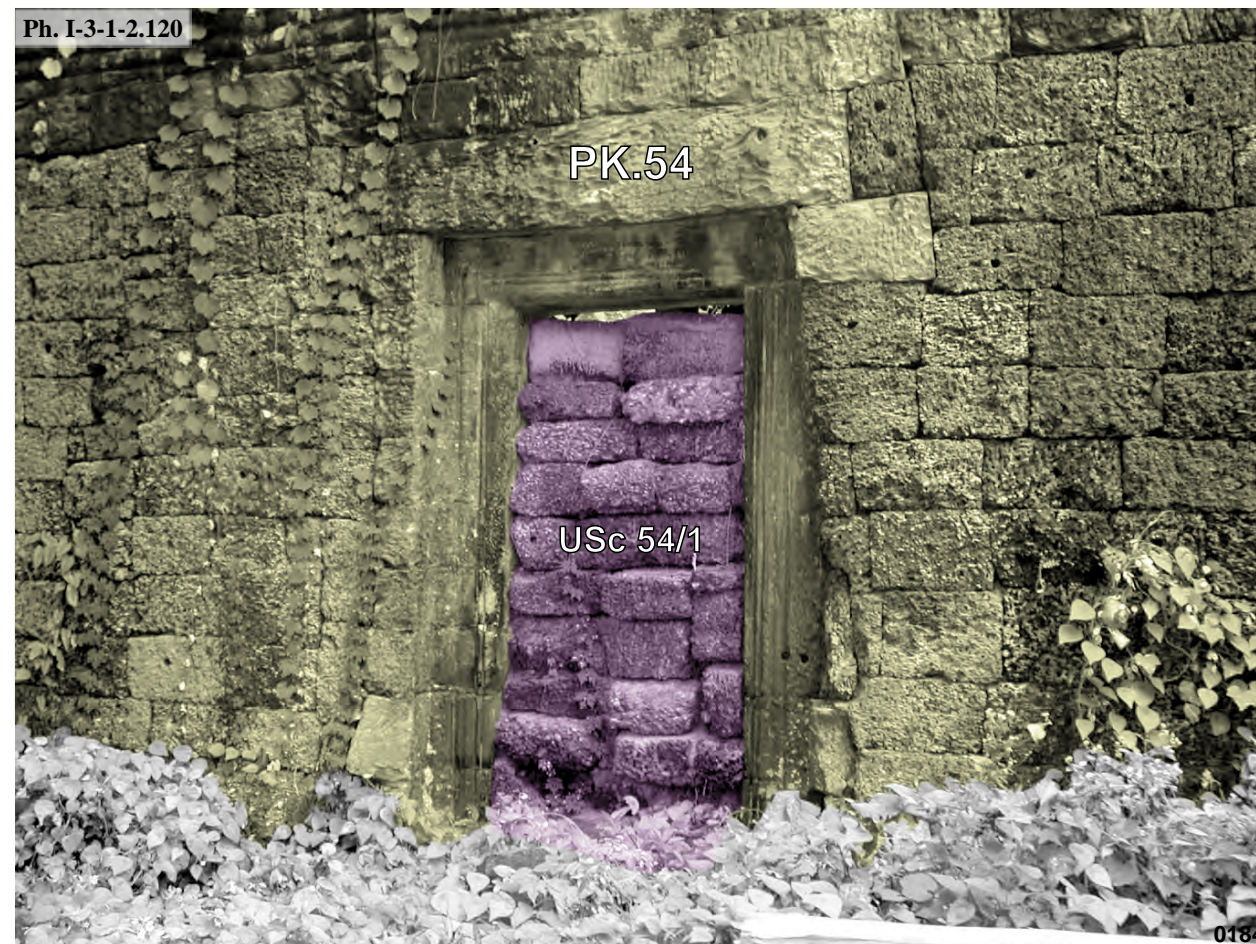
Preah Khan, porte Nord-Ouest de la galerie Ouest de la seconde galerie-enceinte PK.54, face Ouest : USc 54/1
