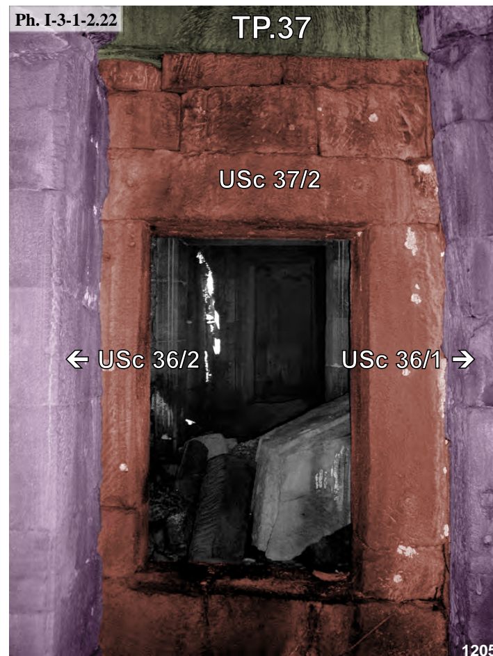
Ta Prohm, galerie Ouest du cloître Est TP.37 , prolongement de la salle de passage TP.31 : USc 37/2, USc 36/1 et USc 36/2
