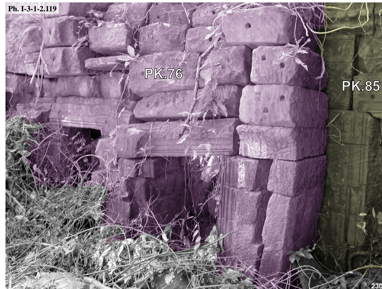
Preah Khan, connexion entre l'avant-corps Est de la tour axiale Ouest PK.85 du complexe Sud et la salle de passage PK.76, face Nord
