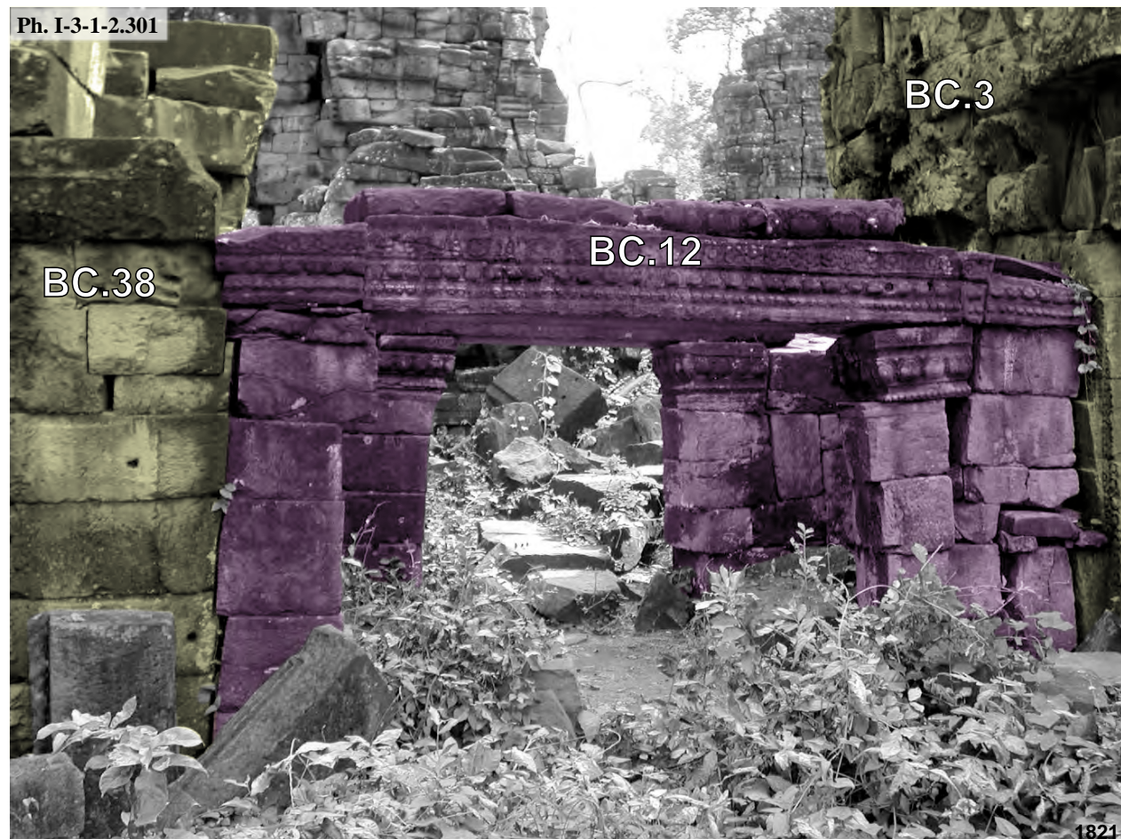
Banteay Chmar, galerie BC.12 entre le bras Sud tour BC.38 et le bras Nord de la la tour BC.3
