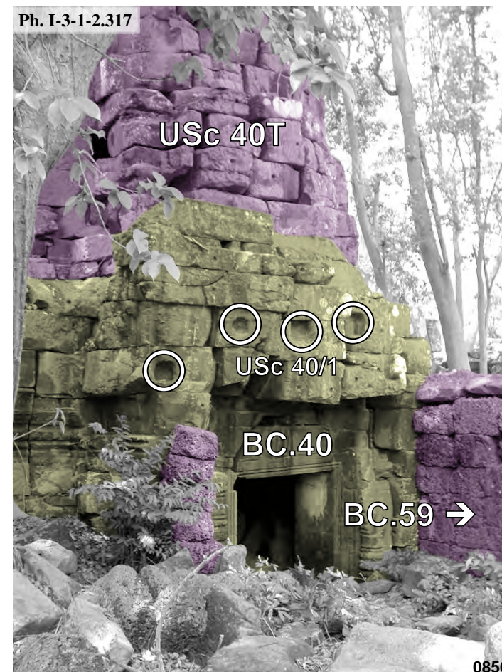
Banteay Chmar, face Est de la tour d'angle BC.40 de la première enceinte et liaison avec la galerie BC.59 de l'enceinte du complexe Est : USc 40/1 et USc 40T
