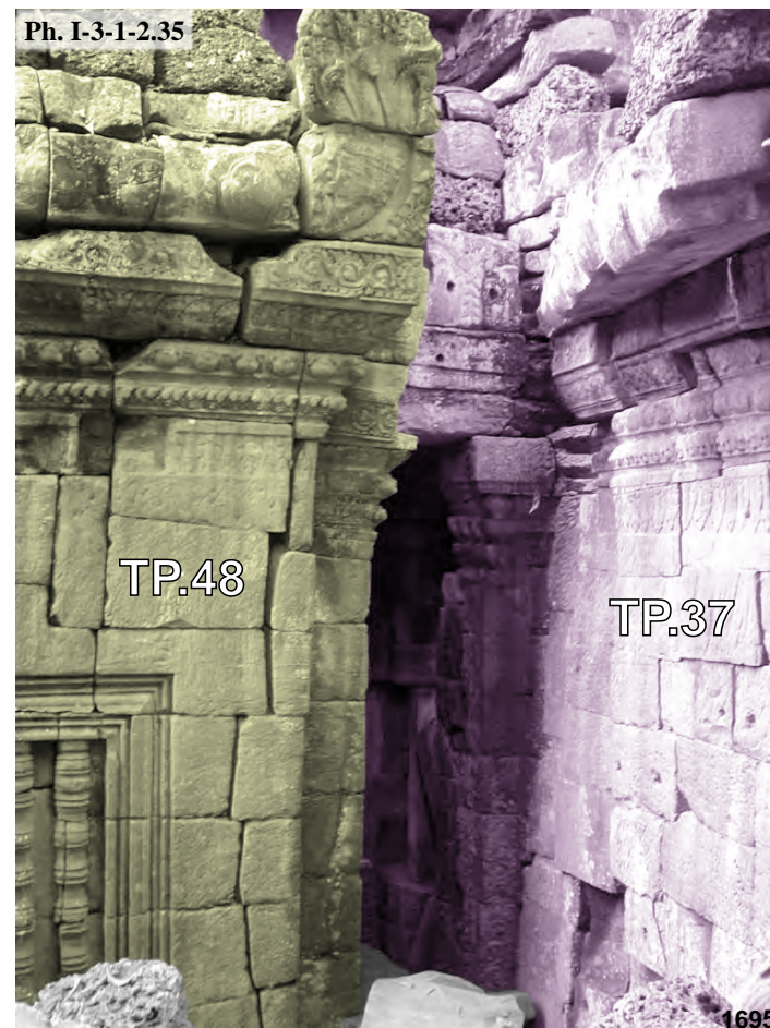
Ta Prohm, connexion entre le cloître Est TP.37 et l'édifice TP.48 , face Nord
