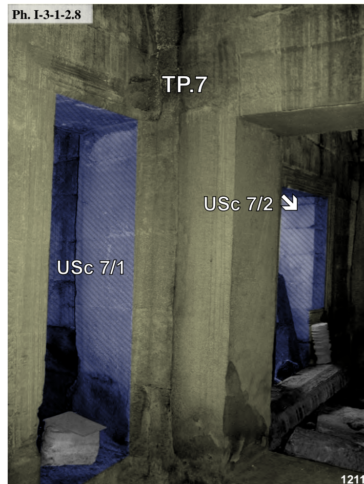
Ta Prohm, porte Est du bras Sud de la tour axiale Est TP.7 de la première enceinte : USc 7/1 et USc 7/2
