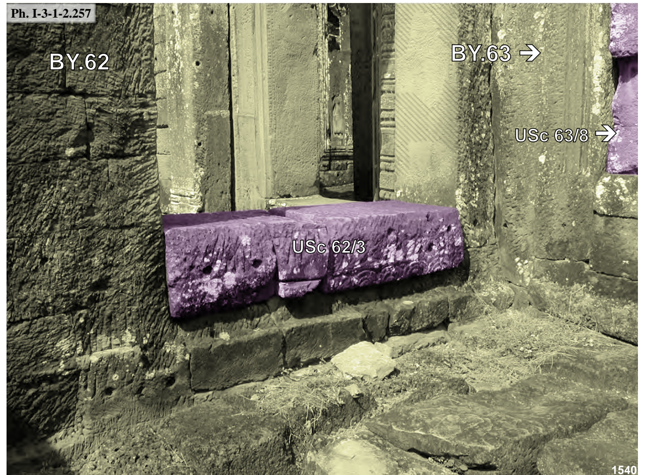
Bayon, vestiges du bouchage de la porte Nord de la galerie Ouest de l'enceinte extérieure BY.62 face Es: USc 62/3
