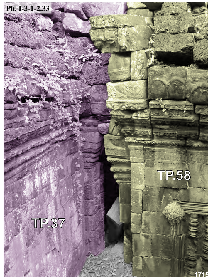
Ta Prohm, connexion entre le cloître Est TP.37 et l'édifice TP.58 , face Sud
