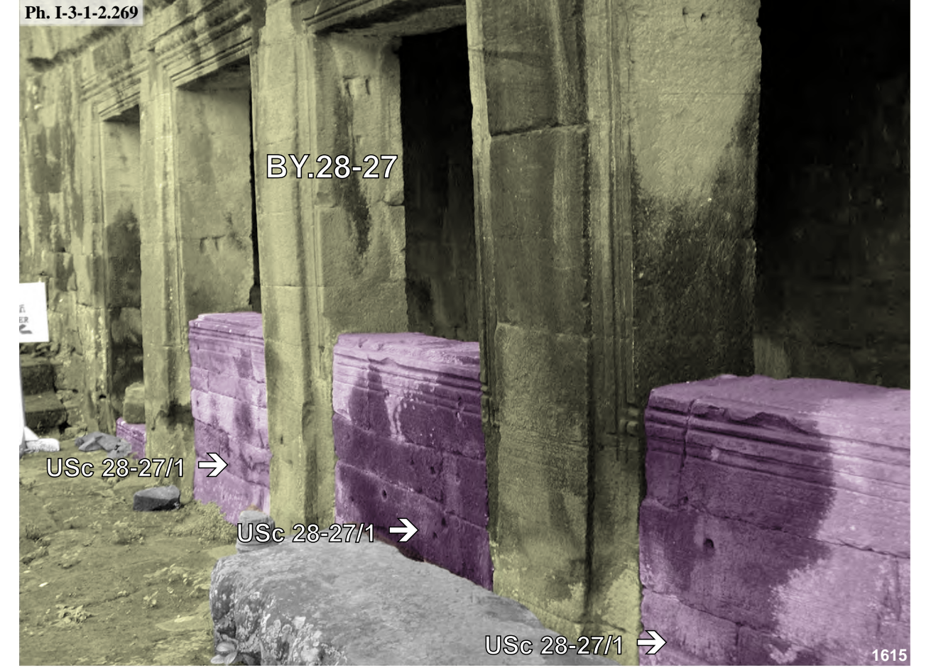
Bayon, bas-côté Nord de la galerie BY.28-27 cour intérieure du second étage, face Nord : USc 28-27/1
