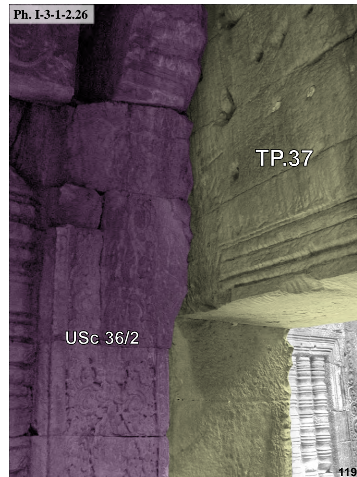
Ta Prohm, fenêtre Sud de la galerie Ouest du cloître Est TP.37 , face Sud : USc 36/2
