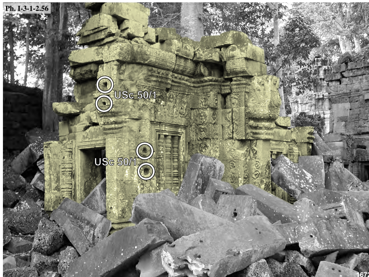
Ta Prohm, bras Est de la tour TP.50 , face Nord : USc 50/1
