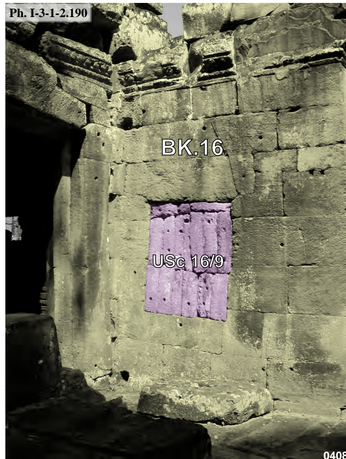
Banteay Kdei, fenêtre Nord du bras Ouest de la tour d'angle BK.16 de la première enceinte, face intérieur Nord : USc 16/9
