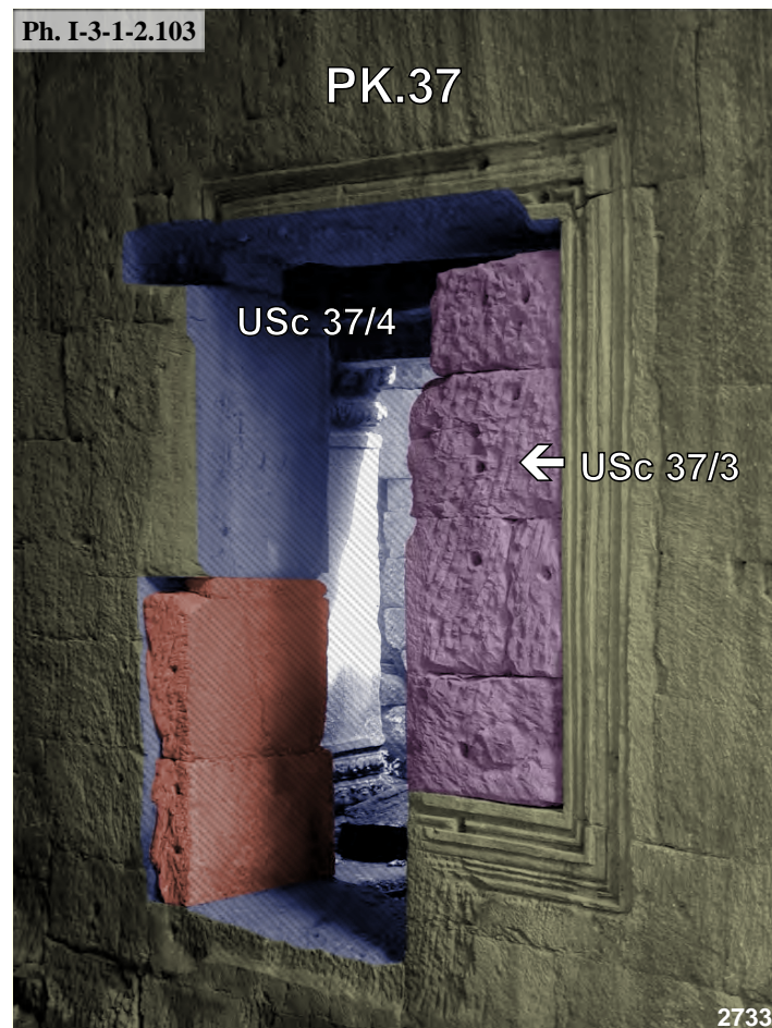
Preah Khan, fenêtre Est du bras Nord du pavillon PK.37 de la première enceinte : USc 37/3 et USc 37/4
