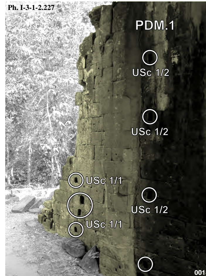
Porte des Morts d'Angkor Thom, Entrée Est du corps principal PDM.1 face intérieure Sud : USc 1/1 et USc 1/2
