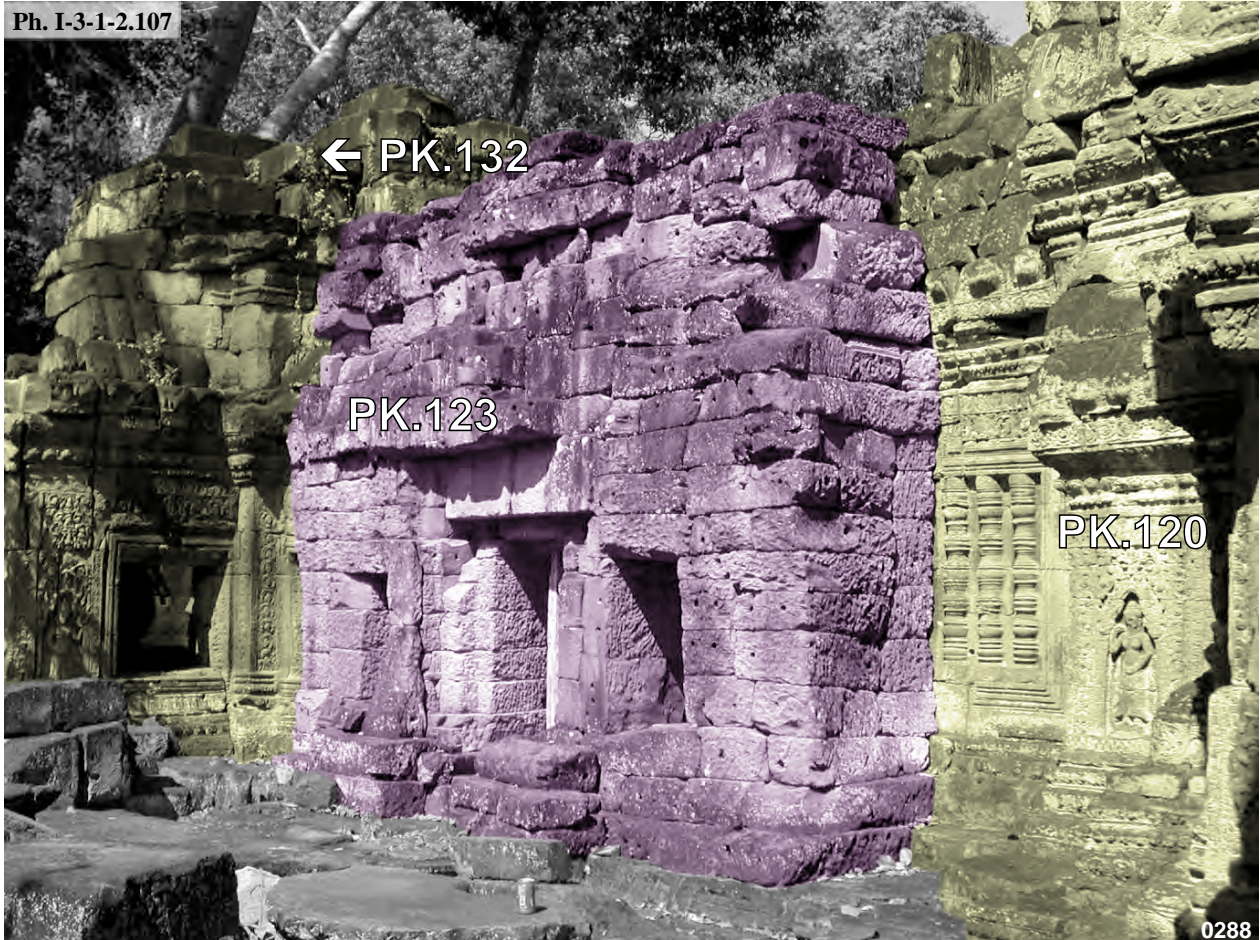
Preah Khan, salle de passage entre l'avant-corps Ouest du sanctuaire central PK.120 et le bras Est de la tour axiale Ouest PK.132 de l'enceinte du complexe Nord, face Sud
