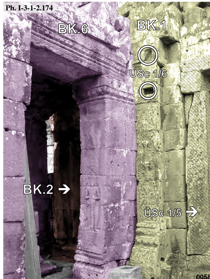
Banteay Kdei, connexion entre l'édifice BK.6 et l'avant-corps Est du sanctuaire central BK.1 : USc 1/6
