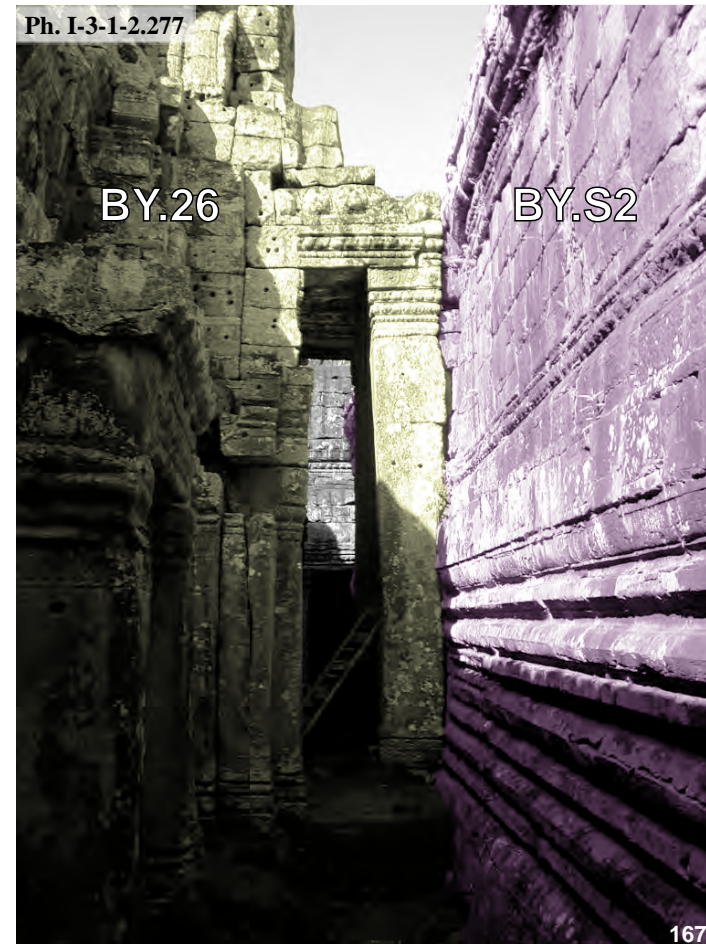
Bayon, connexion entre le porche de l'avant-corps Nord de la tour BY.26 et le soubassement du troisième étage face Est
