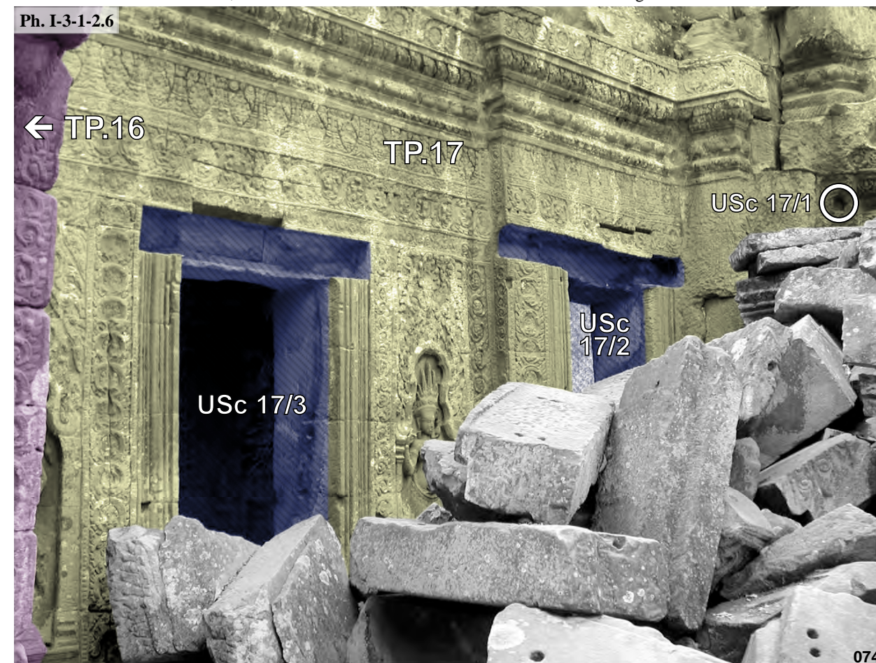
Ta Prohm, fenêtres Est de l'avant-corps et du bras Sud de la tour axiale Ouest TP.17 de la première enceinte, face Est : USc 17/1, USc 17/2 et USc 17/3
