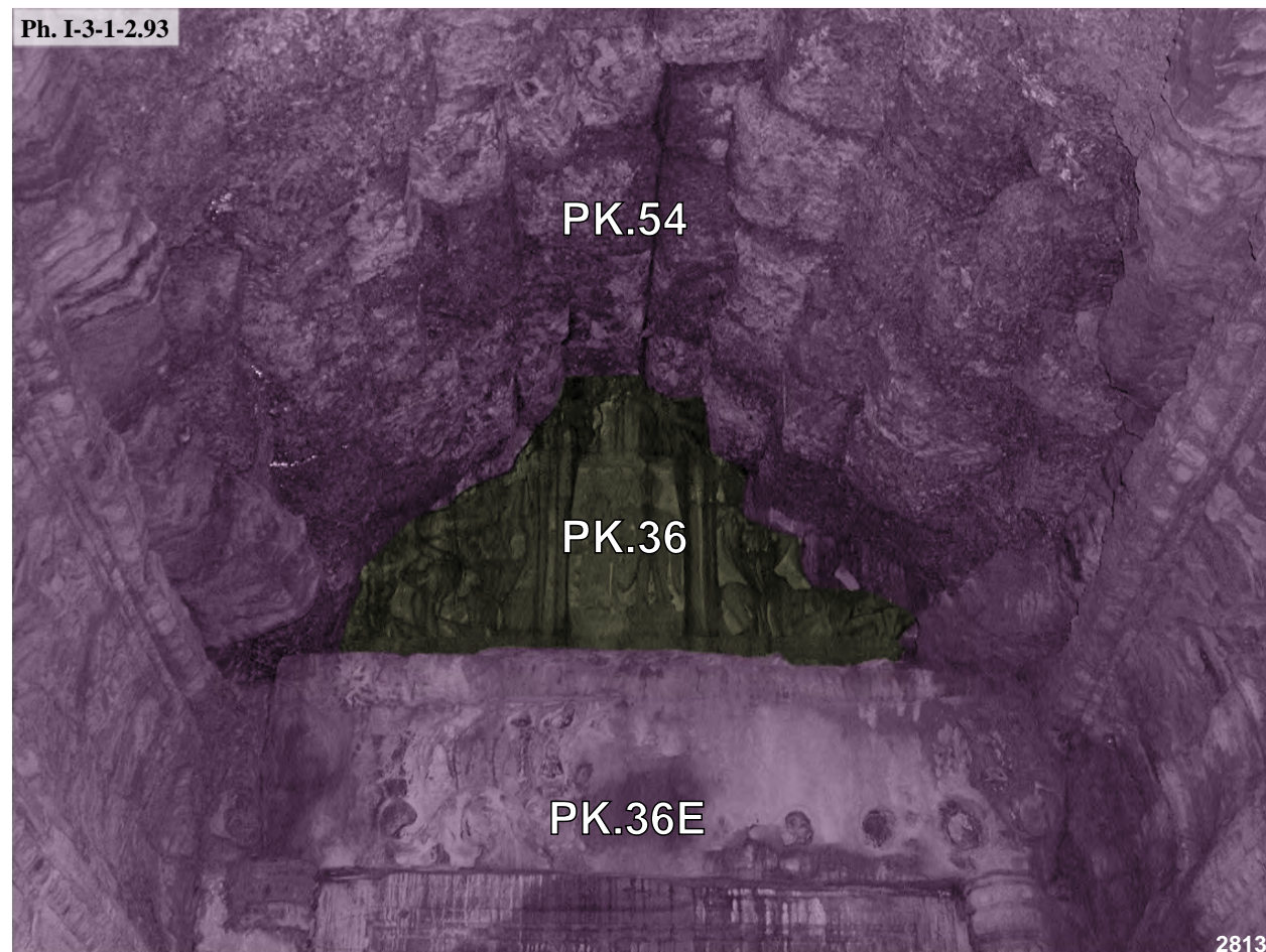
Preah Khan, englobement du fronton du porche de l'avant-corps Est de la tour axiale Est PK.36 de la première enceinte dans la partie Est de la seconde galerie-enceinte PK.54
