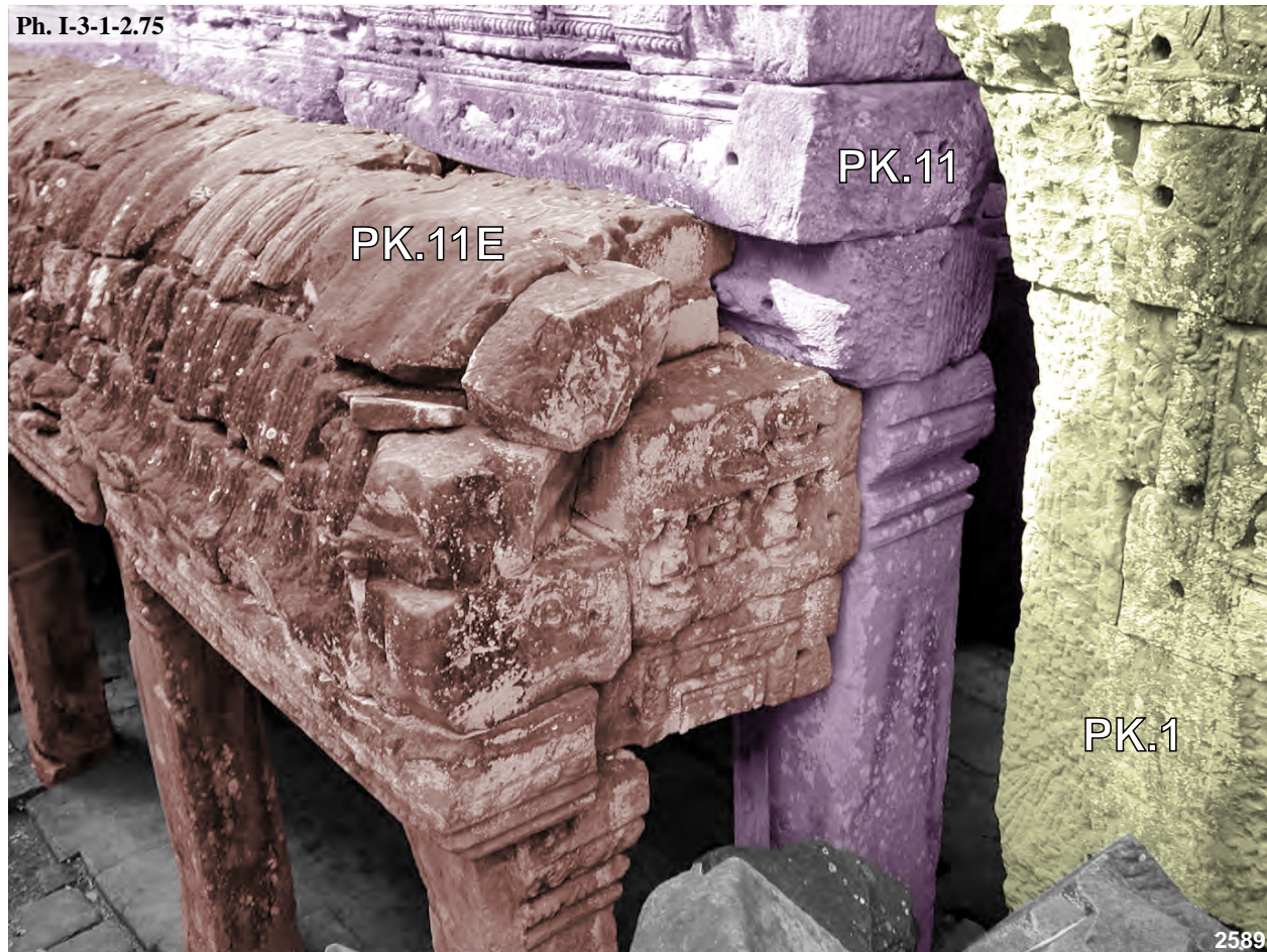
Preah Khan, liaison entre la galerie axiale Sud PK.11 avec l'avant-corps de Sud du sanctuaire central et connexion avec le bas-côté 11E, face Nord
