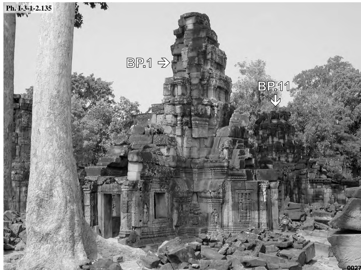
Banteay Prei, sanctuaire central BP.1 angle Nord-Est
