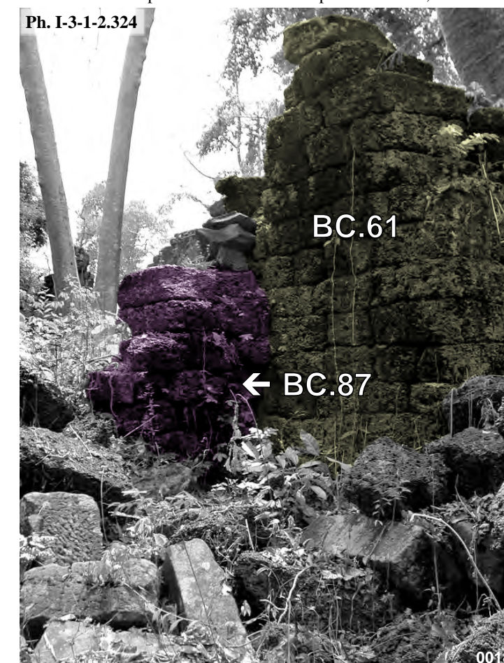
Banteay Chmar, connexion entre le pavillon d'angle Nord-Est BC.61 de l'enceinte du complexe Est et le mur de la seconde enceinte BC.87
