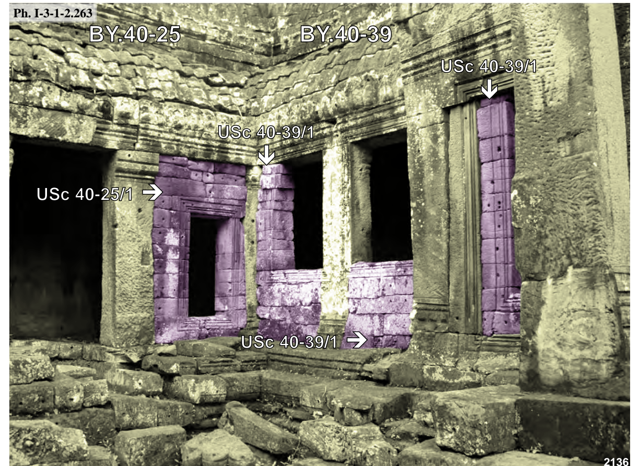
Bayon, cour Sud-Est du second étage, bas-côté de la galerie BY.40-39 et BY.40-25 angle Nord-Ouest : USc 39/1, USc 40-39/1 et USc 40-25/1
