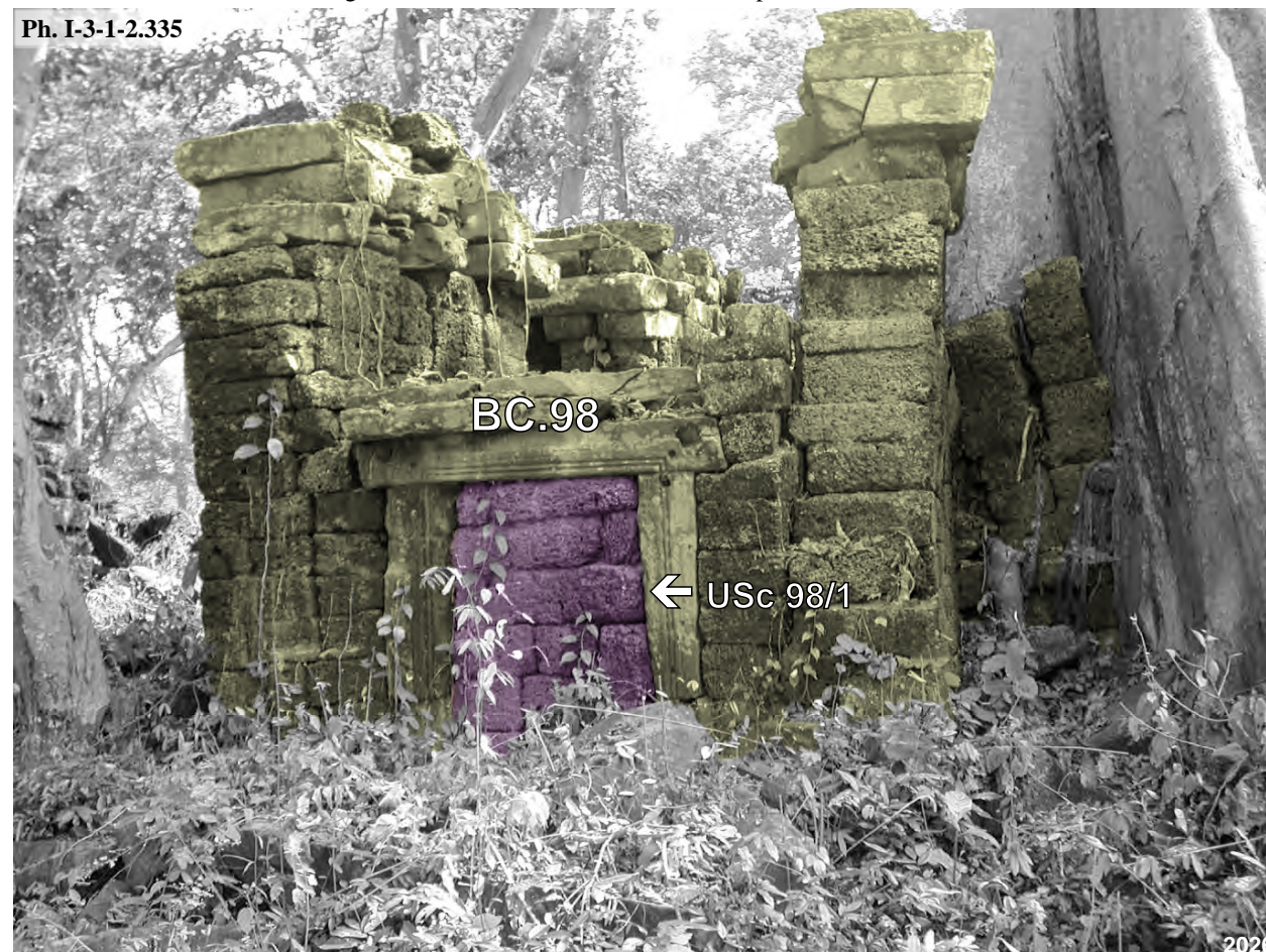
Banteay Chmar, porte Nord-Est de l'enceinte du complex Sud, face Nord : USc 98/1
