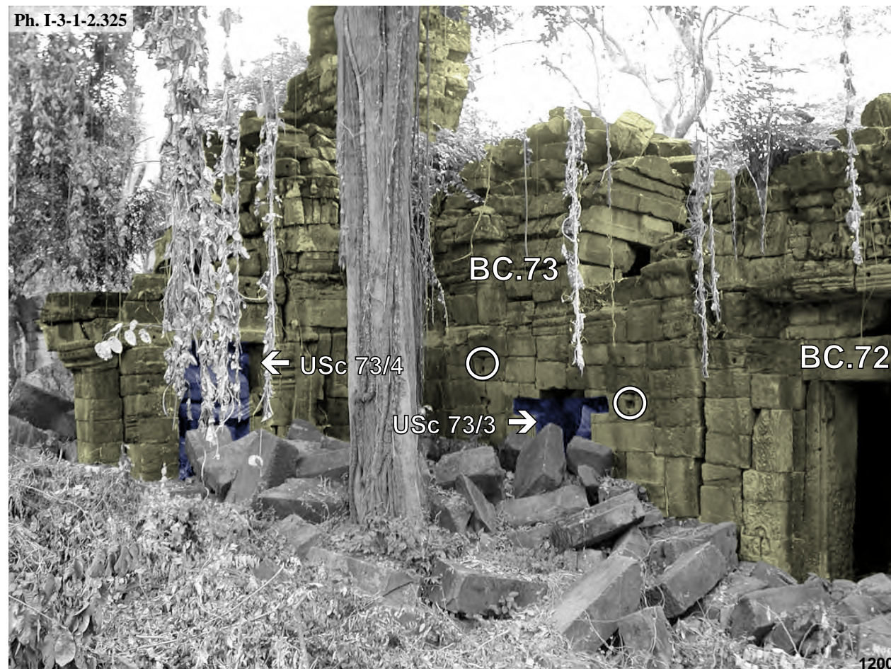
Banteay Chmar, loggia Sud-Est 73SO de la tour axiale BC.73 de l'enceinte du complexe Ouest : USc 73/3
