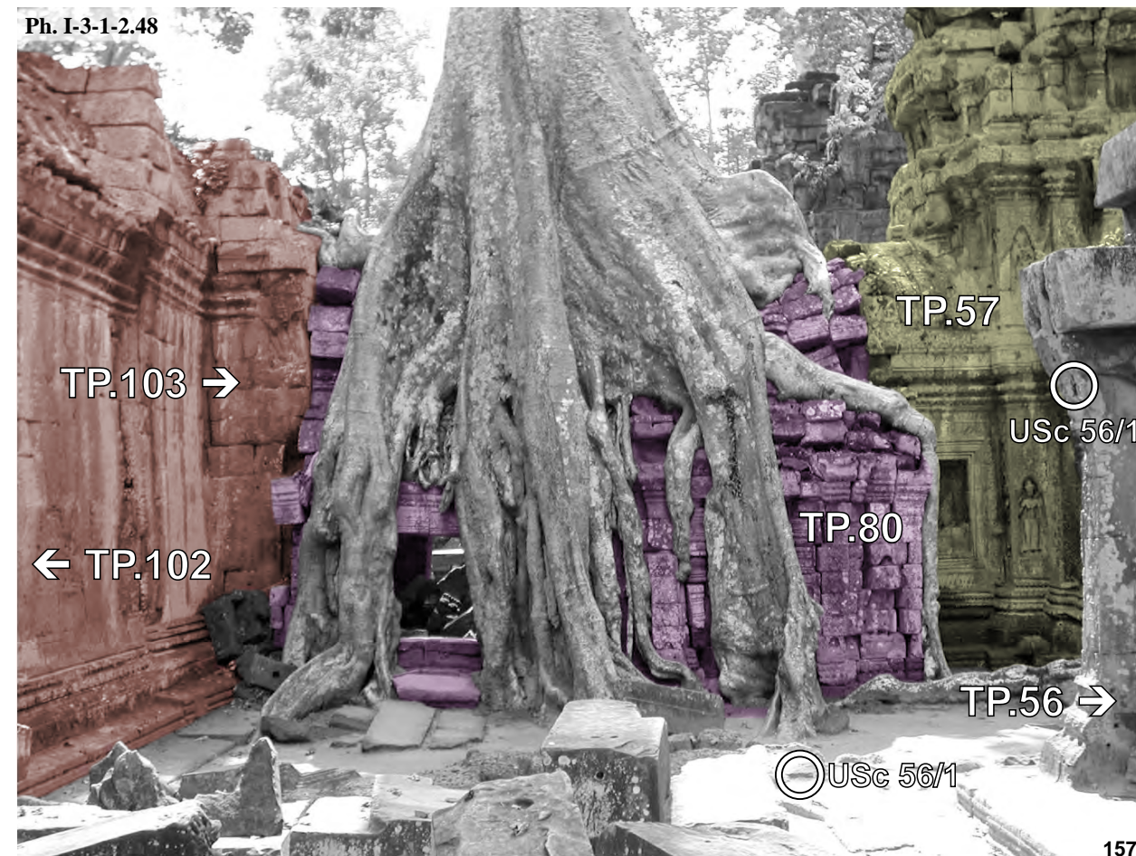
Ta Prohm, salle de passage TP.80 reliant le pavillon latéral Nord TP.103 de la galerie Est de la troisième enceinte et le bras Est de la tour TP.57 : USc 56/1
