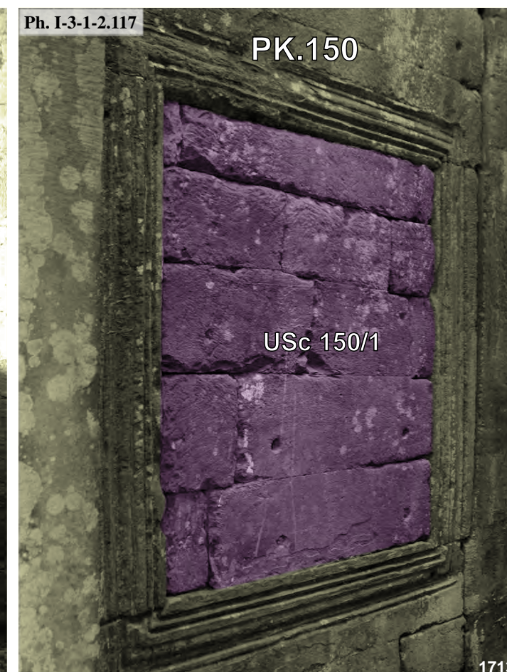
Preah Khan, fenêtre Sud de bras Est du pavillon PK.150 de la troisième enceinte, vue intérieure : USc 150/1
