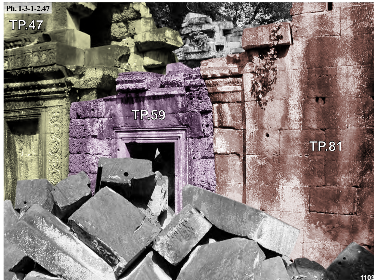
Ta Prohm, édifice TP.59 reliant le bras Est de la tour TP.47 et l'avant-corps du pavillon axial Est TP.81 de la troisième galerie-enceinte, face Sud
