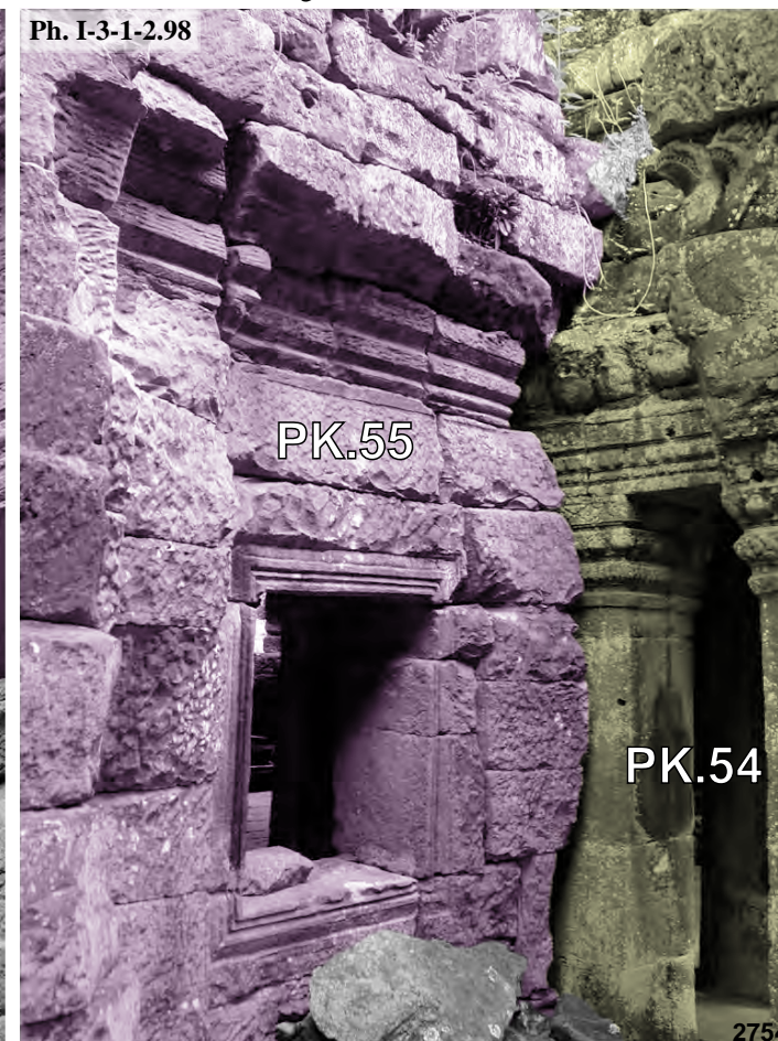
Preah Khan, connexion entre la galerie de la seconde enceinte et l'avant-corps Est de la tour PK.55 , face Sud
