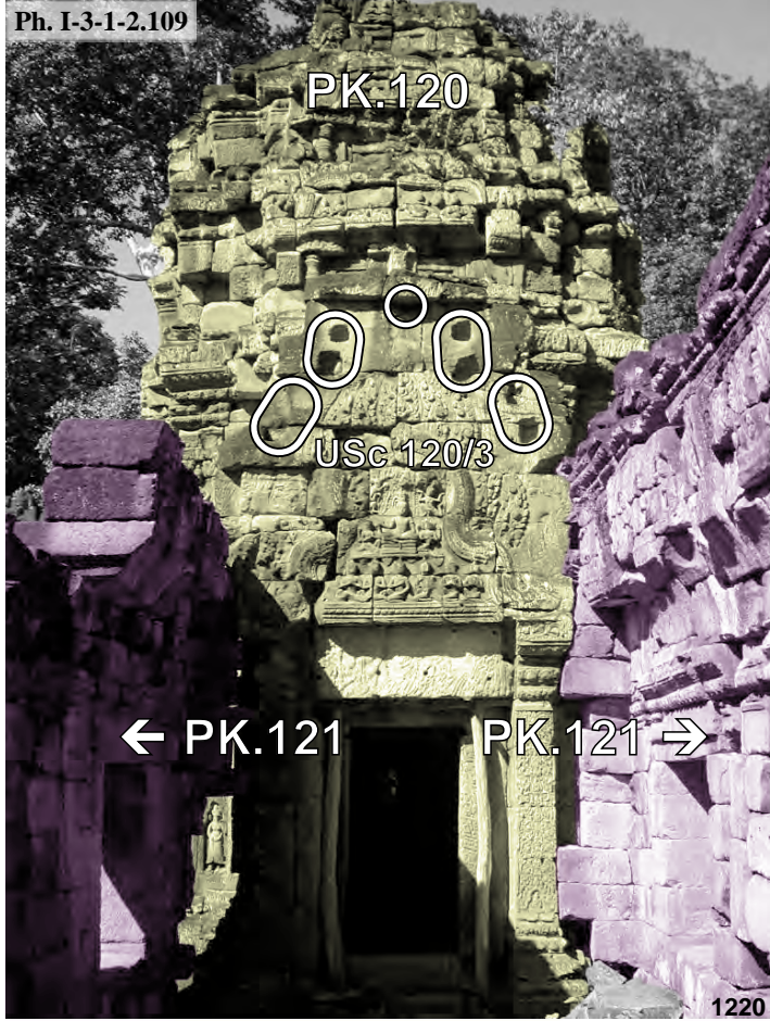
Preah Khan, fronton de l'avant-corps Est PK.120 du sanctuaire central du complexe Nord, vue de la salle passage PK.121
