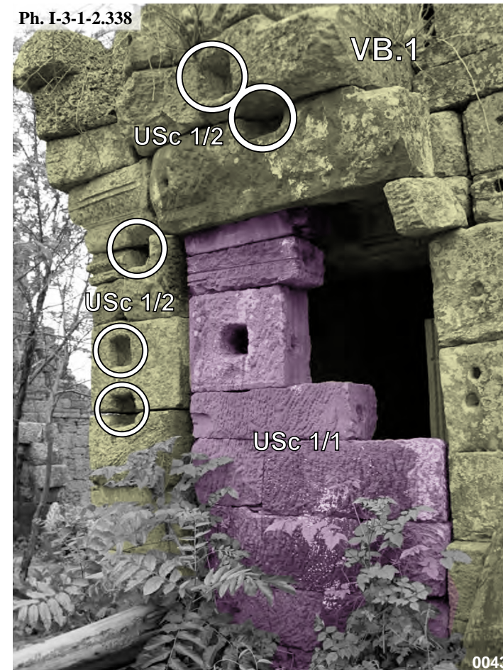
Vat Banon, loggia Sud-Est du sanctuaire central VB.1 face Est : USc 1/1 et USc 1/2
