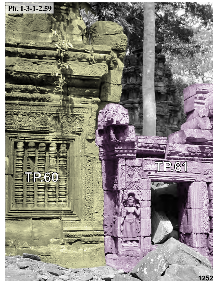
Ta Prohm, connexion entre l'avant-corps Est de la tour centrale TP.60 du cloître Sud avec l'édifice TP.61
