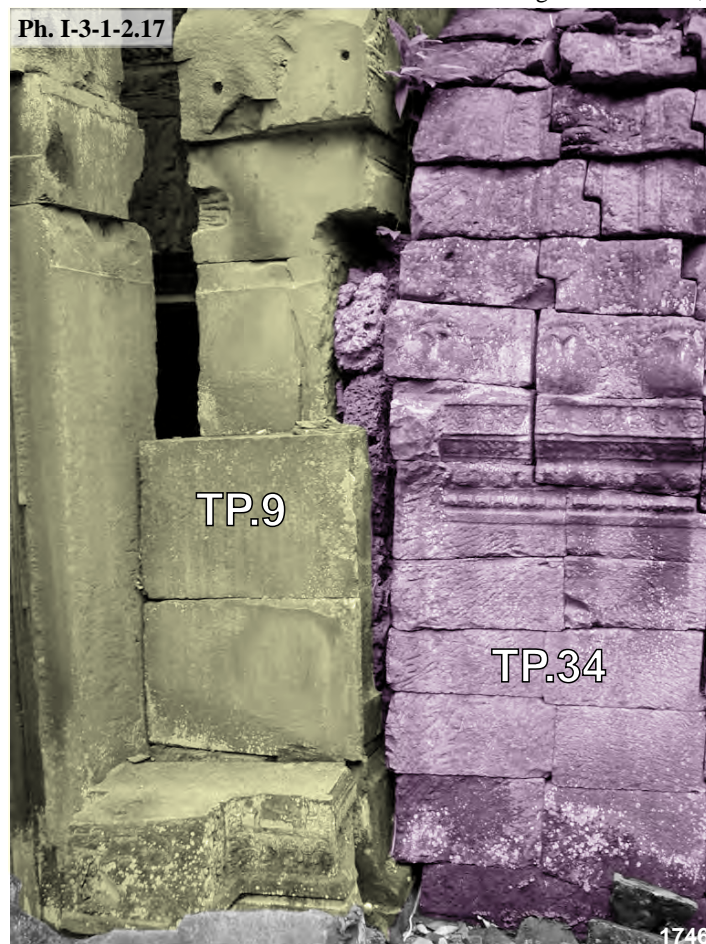
Ta Prohm, connexion entre l'avant-corps Sud de la tour d'angle Sud-Est TP.9 de la première enceinte avec la salle de passage TP.34 , face Sud
