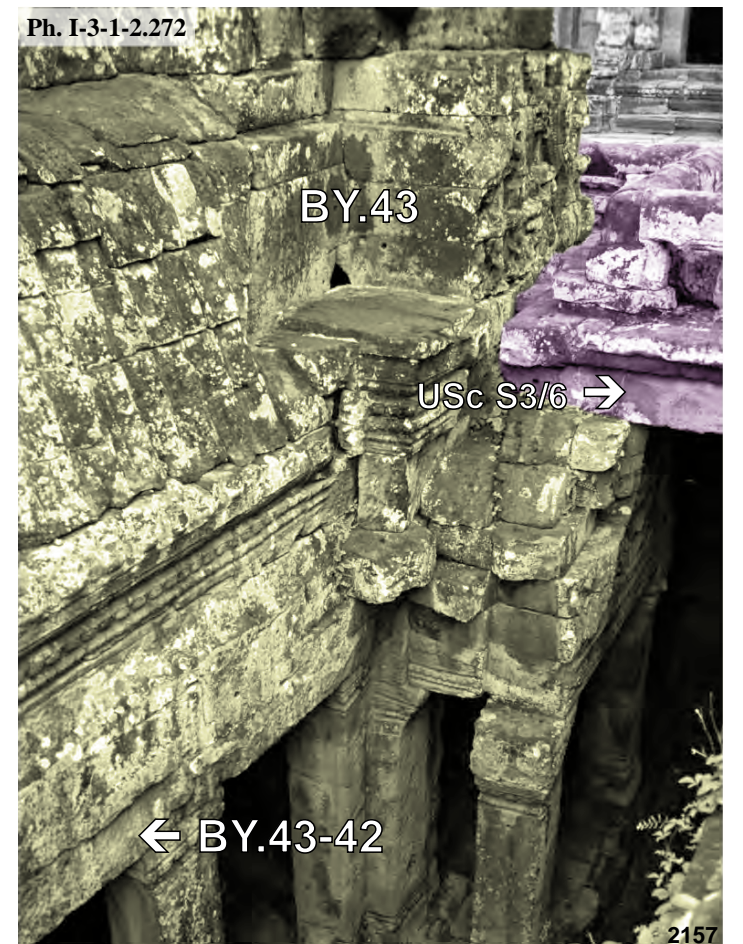
Bayon, porche Est de la tour BY.43 et extension de la terrasse du troisième étage S3/6
