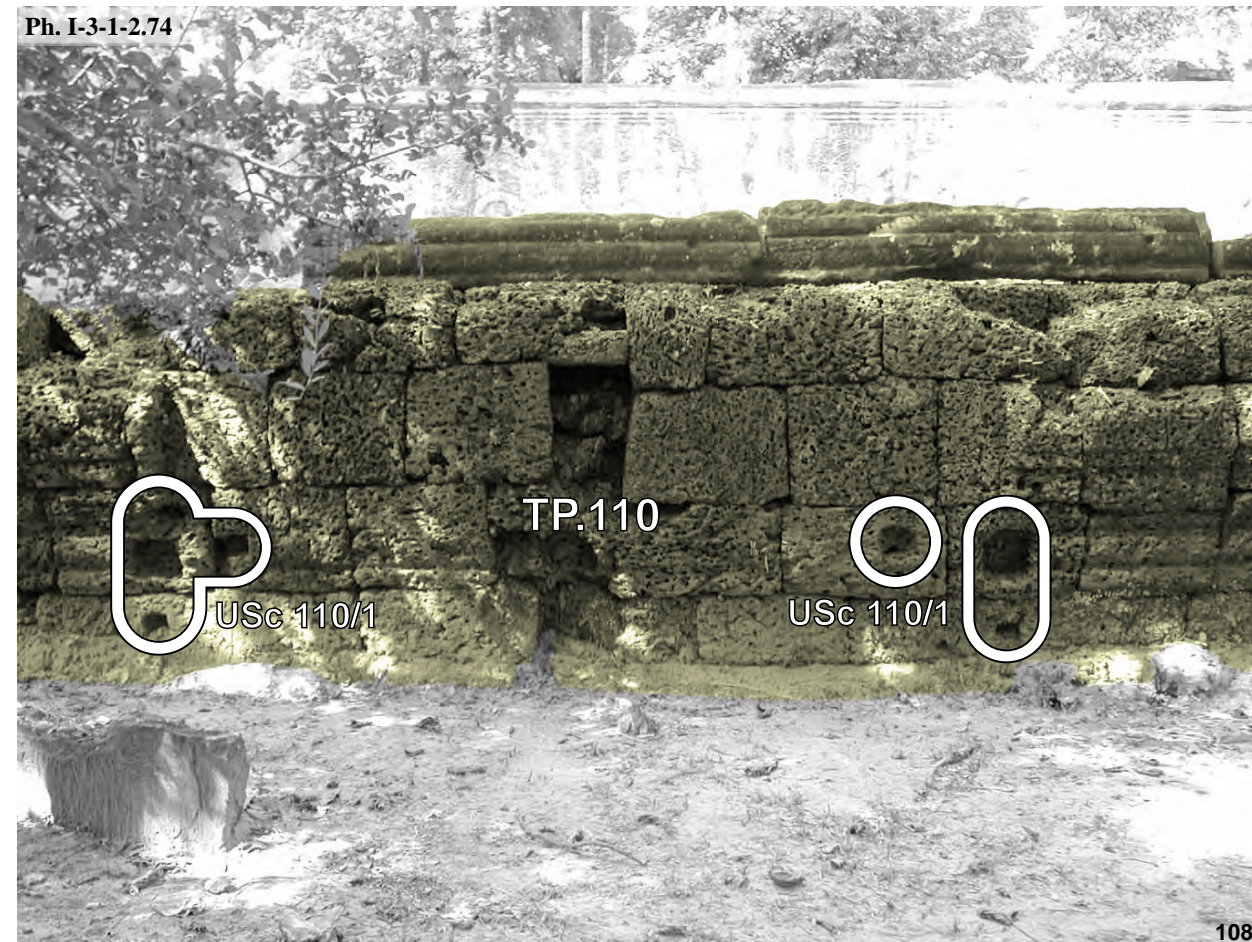
Ta Prohm, mur d'enceinte intérieur Nord TP.110 : USc 110/1
