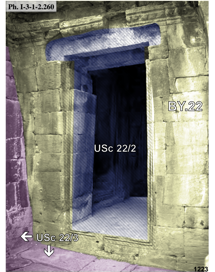
Bayon, porte Est de l'avant-corps Sud du pavillon axial Est de l'enceinte intérieure BY.22 face Est : USc 22/2
