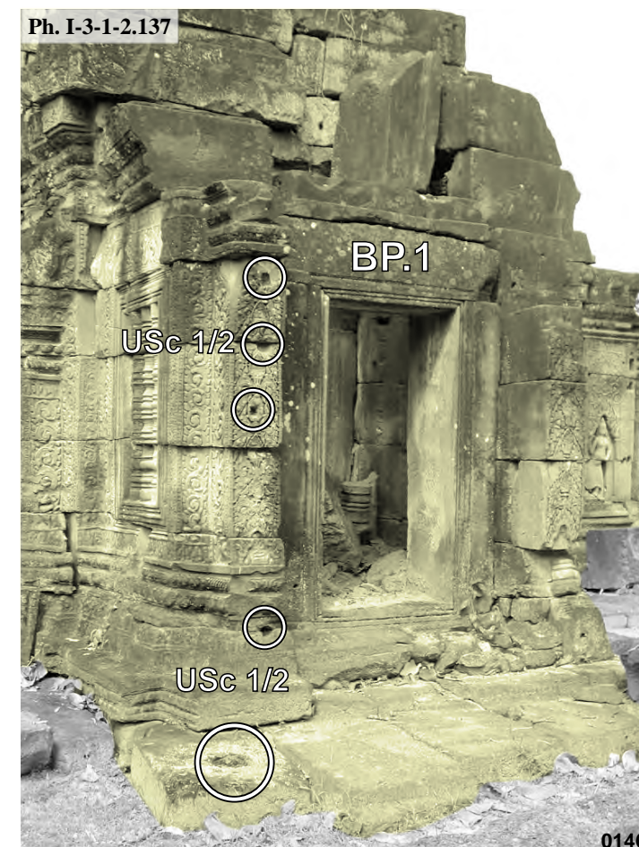
Banteay Prei, avant-corps Sud du sanctuaire central BP.1 face Sud : USc 1/2
