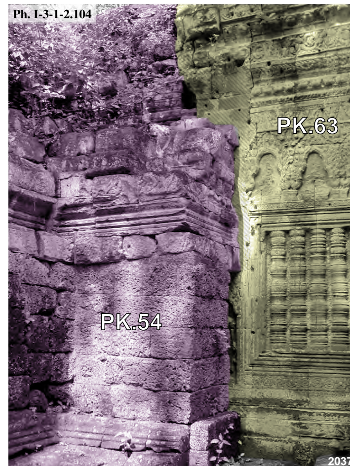
Preah Khan, connexion entre la galerie de la seconde enceinte et le bras Ouest de la tour axiale Est PK.63
