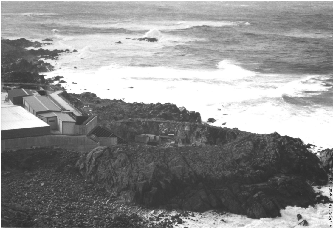
Photo 31 - Détail de la construction de la pisciculture de Cabo Vilán
