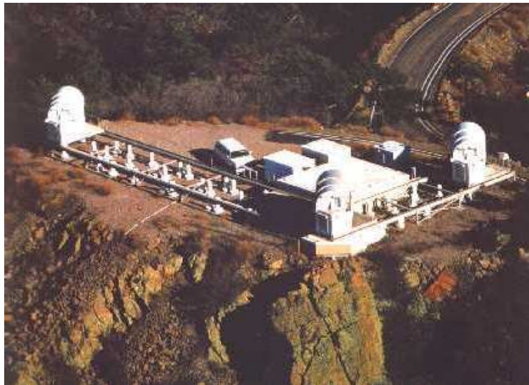
FIG. 2.17 – L'interféromètre IOTA, Infrared and Optical Telescopes Array, avec ses trois télescopes disposés selon un L, est basé sur le Mont Hopkins, Arizona, USA.
