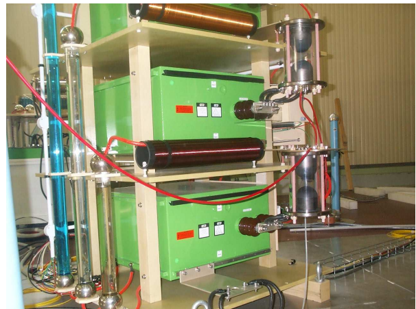
(c) : Les modules de stockage capacitifs et leurs éclateurs à gaz pressurisés associés
