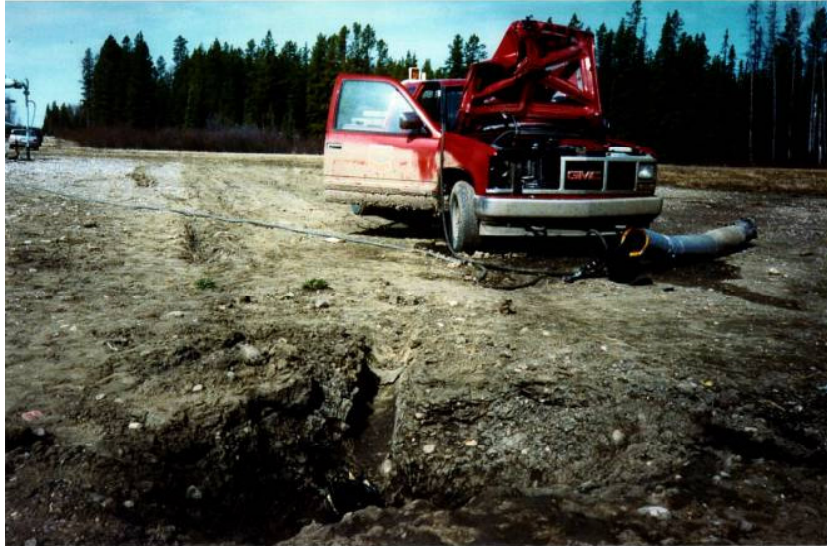
Figure 0.3. Accident de conduite pétrolière causé par un projectile d'hydrates en cours de dissociation.
