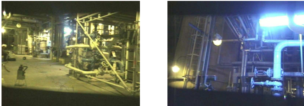
FIG. 3.5 – Photographies prises sur site par la caméra du scanner Soisic
