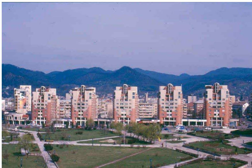
Figure 29 : Les blocs ceinturant Baia Mare (cliché J. Cristescu, 2001)
