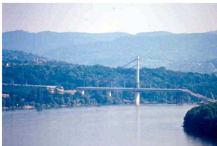
Figure 60 : Le pont de Zvezdij plongeant dramatiquement dans le Danube (Cliché J. Cristescu, 2002)
