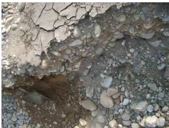
FIG. 1.2 – Vue de dessus du sol d'un bassin colmaté
