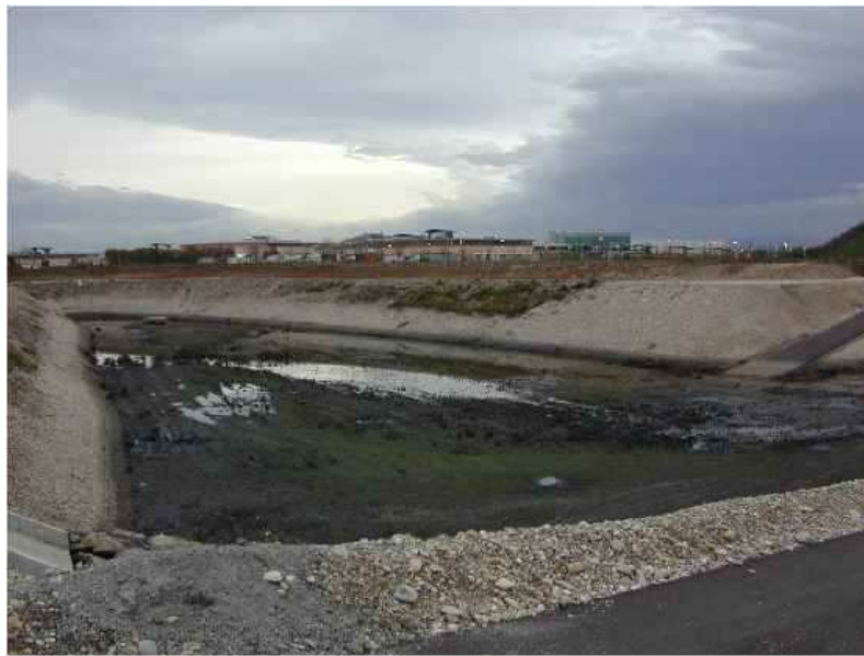
FIG. 1.1 – Bassin d'infiltration d'eaux pluviales de l'Est Lyonnais
