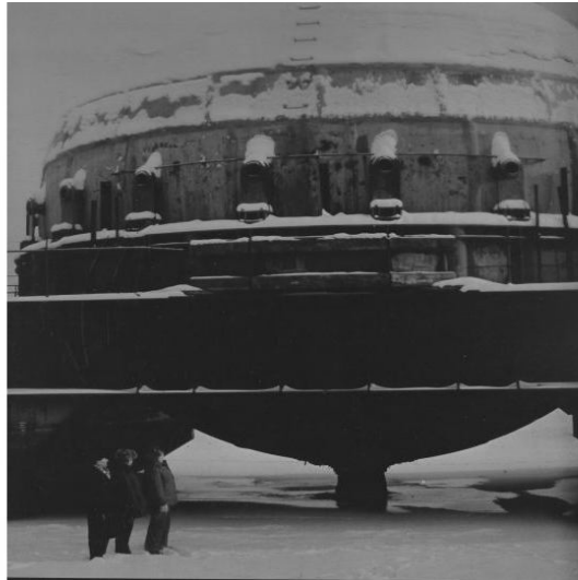
FIG. 1 – Chambre à explosifs de l'Académie Russe des Sciences.
