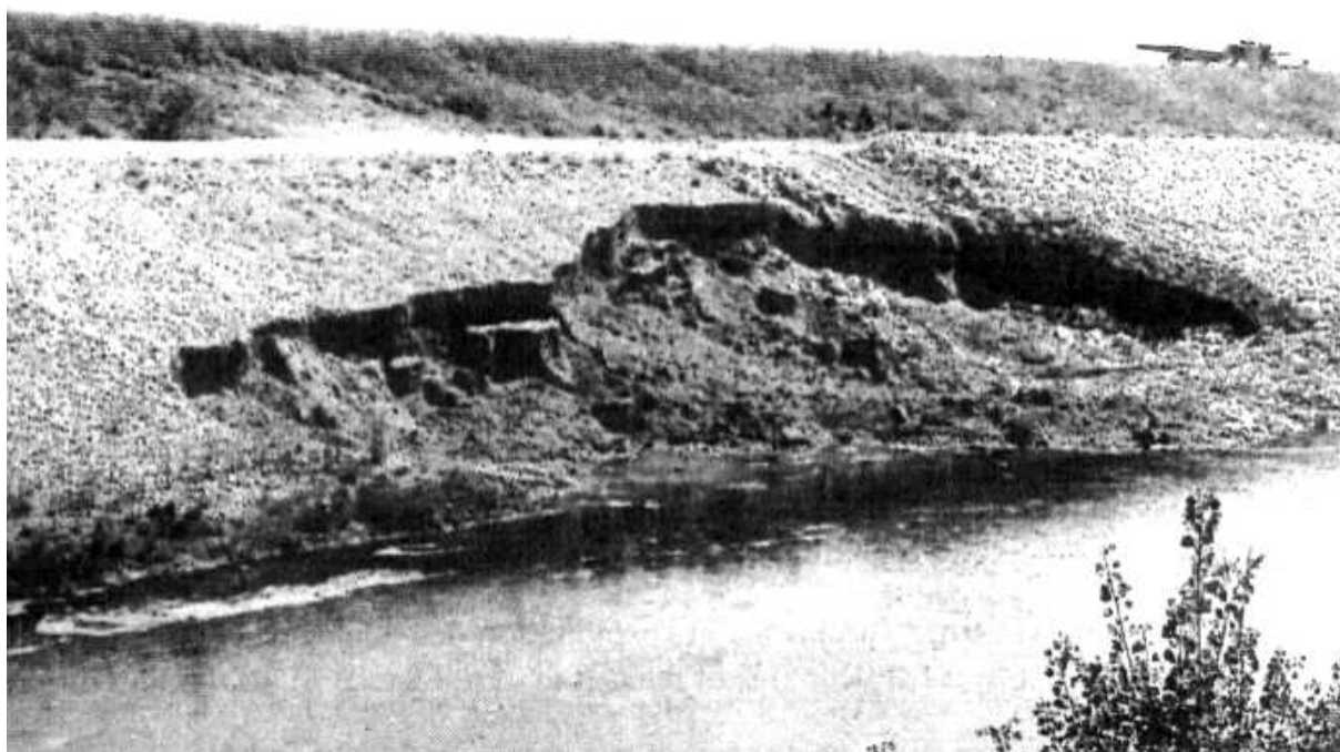
figure 2-18, Exemple de rupture de talus aval (Brun, 1993)
