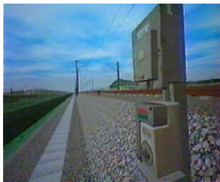
7. Lors d'un problème, le conducteur doit prendre une clé moteur sur les voies pour débloquer l'aiguillage.
