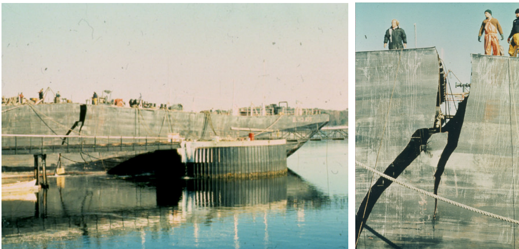
figure I. 1 : Photographie d'un liberty ship en acier bas carbone [Bouchard N-H, 1978]. Selon le rapport d'expertise de R.M. Pelloux, la fissure se serait amorcée à la jonction du pont et de la coque.
