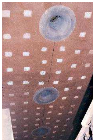
Figure 1.3 – Brûleurs de voûte.
