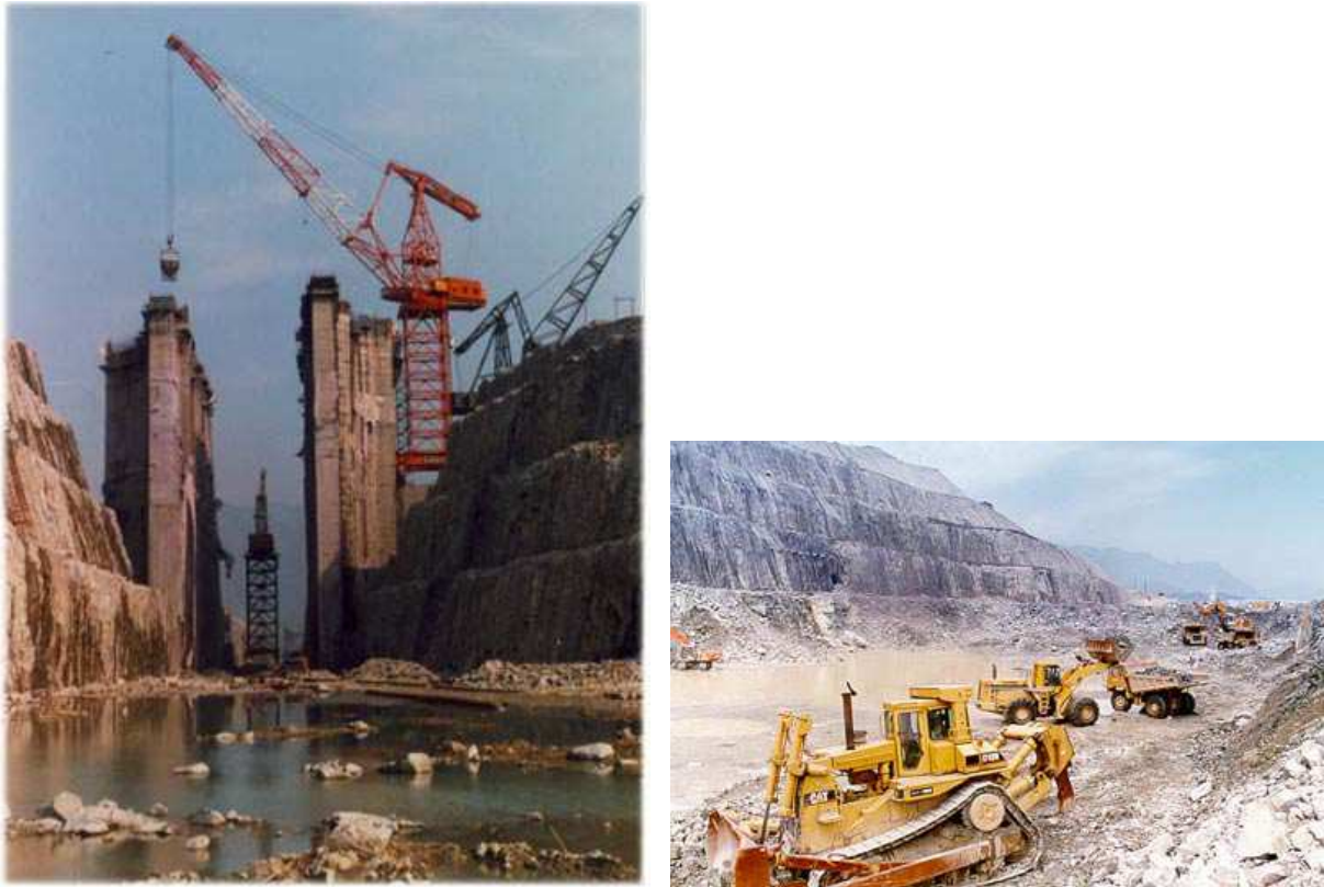
Figure I-6 : Chantiers de construction de l'écluse à bateaux temporaire, d'après CTGPC (1997).
