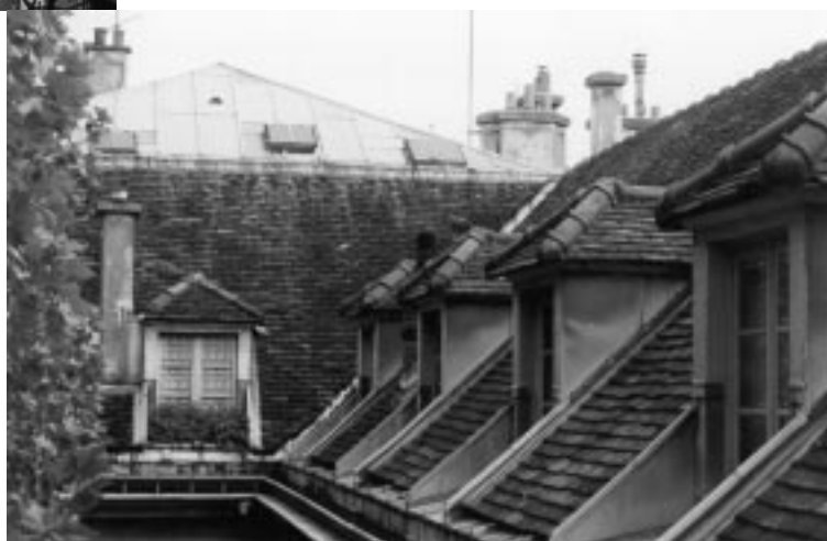
Toiture Tuile 2 (tuile plate et zinc)
