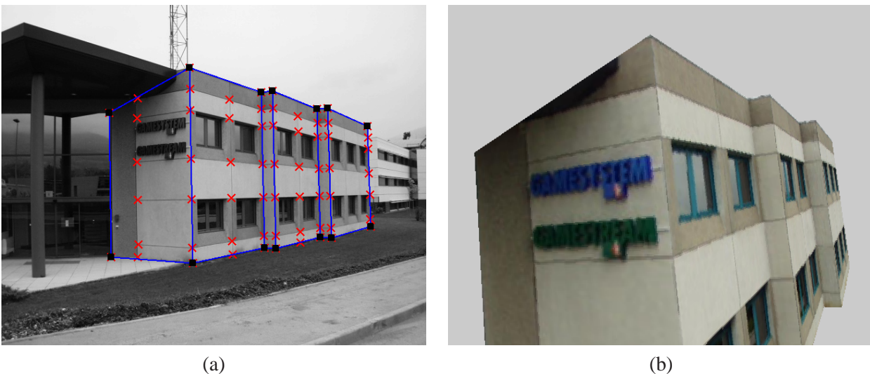
FIG. A.1 – Exemple typique d'une scène plane par morceaux. (a) montre une image avec des points et leur segmentation en plans. (b) montre le modèle 3D texturé obtenu par notre algorithme.
