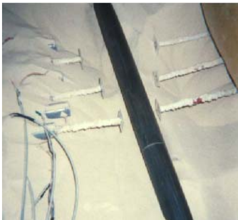
Vue des 6 capteurs LVDT 25mm mesurant les mouvements du sol
