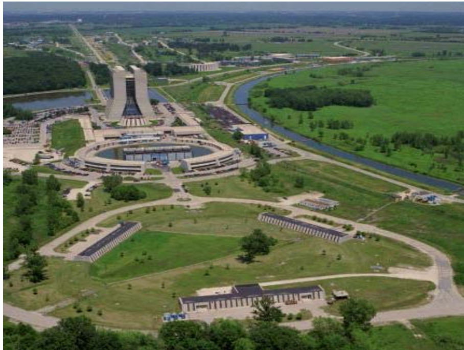
FIG. 2.1 – Vue du bâtiment principal du laboratoire Fermilab, le “Wilson Hall”. A partir de celui-ci, et en descendant vers le premier plan, se trouvent le “Booster”, puis l’anneau de stockage des antiprotons. L’arc de cercle sur la droite révèle l’anneau du Tevatron, enterré à une dizaine de mètres de profondeur.
